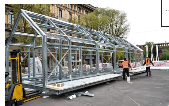
Si procede con i pannelli in copertura e in parete.
