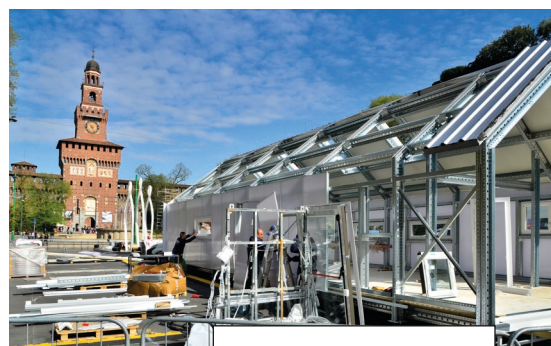
Si installano i pannelli di policarbonato.
