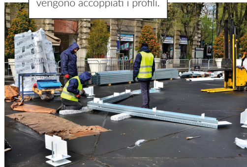
...si collegano con le travi trasversali.
