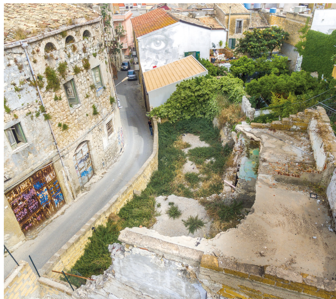
Figura 11.3. Vista aerea del lotto di progetto
