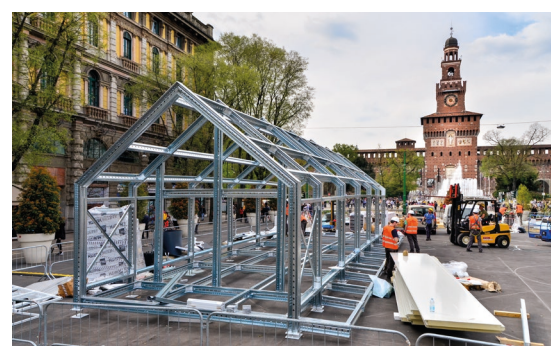
Si procede con i pannelli in copertura e in parete.
