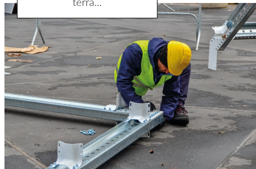
I portali vengono montati a terra...
