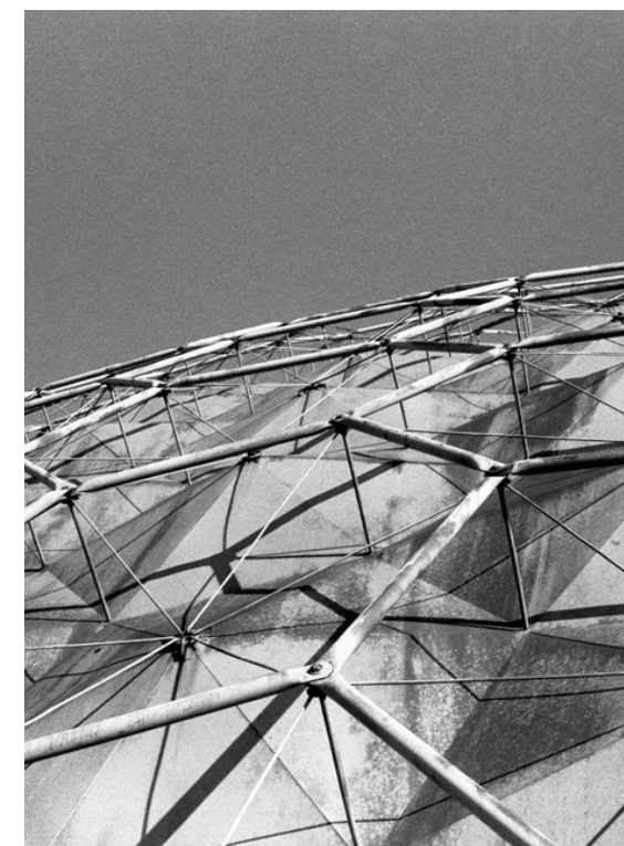
Figura 9.18. Struttura reticolare geodetica, Buckminster Fuller
