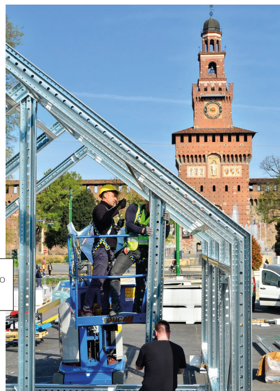
...per il montaggio dei pilastri.
