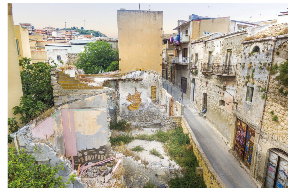
Figura 11.1. Vista aerea del lotto di progetto
