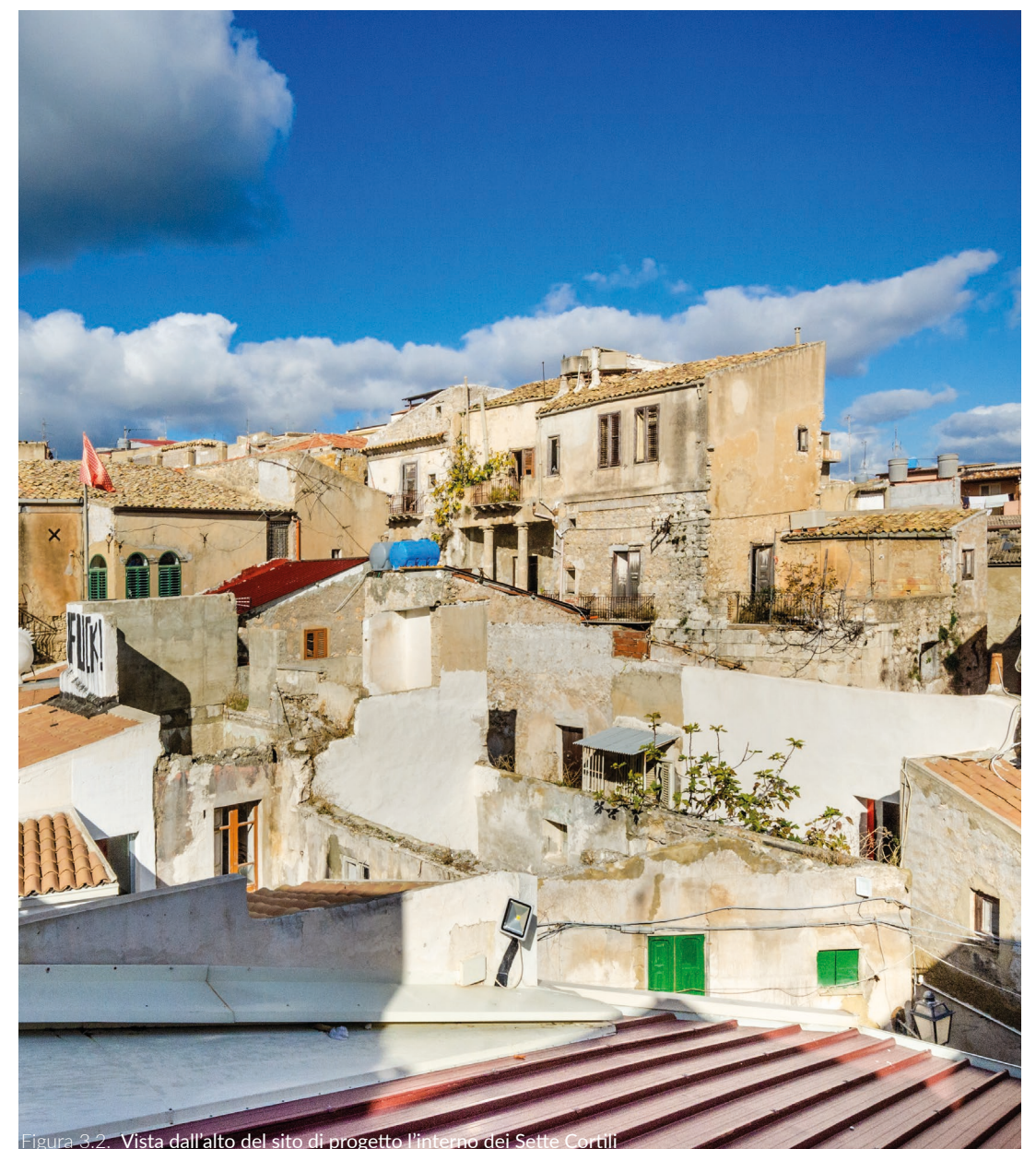
Figura 3.2. Vista dall'alto del sito di progetto l'interno dei Sette Cortili
