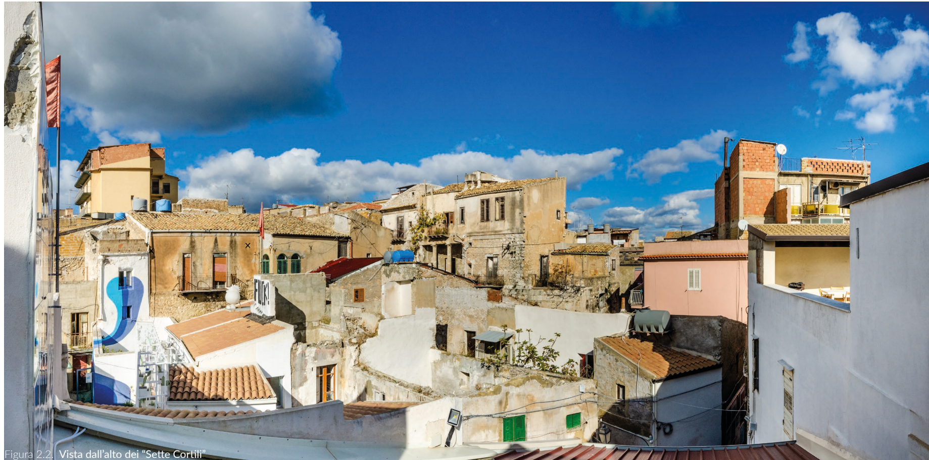
Figura 2.2. Vista dall'alto dei "Sette Cortili"
