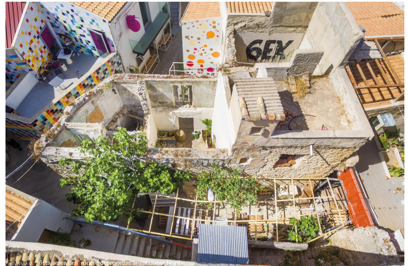
Figura 3.6. Vista aerea dell' rudere di progetto, angolazione Nord
