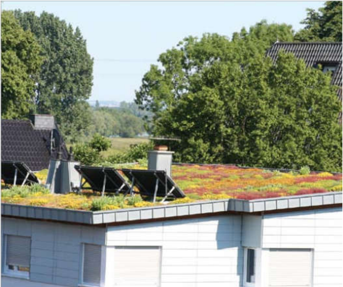
PICUTRE 4.13 GREEN ROOF
