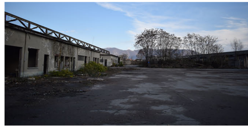
Utilizzo della struttura preesistente come area di stoccaggio
