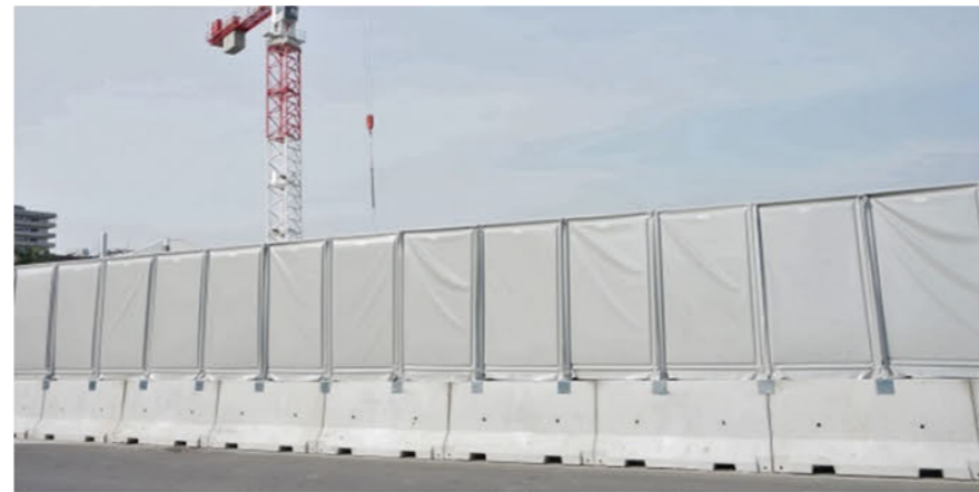
Posizionamento delle recinzioni e degli accessi al cantiere
