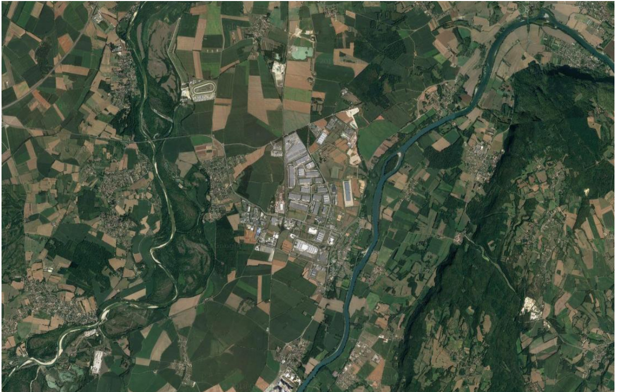
Figure 49 - Aerial view of the Parc Industriel Plaine de l'Ain
