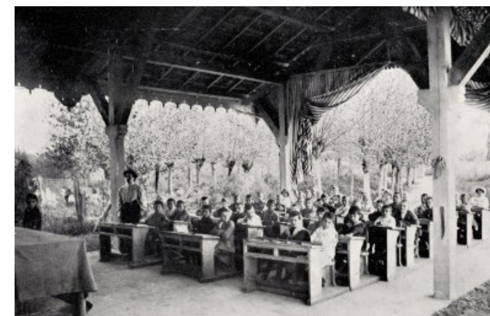
Figura 94: tettoia in legno della scuola Camillo Aita; fonte: 147.162.43.217/musedu/nella_scuola_diieri/glossario/scuole-all-aperto.html
