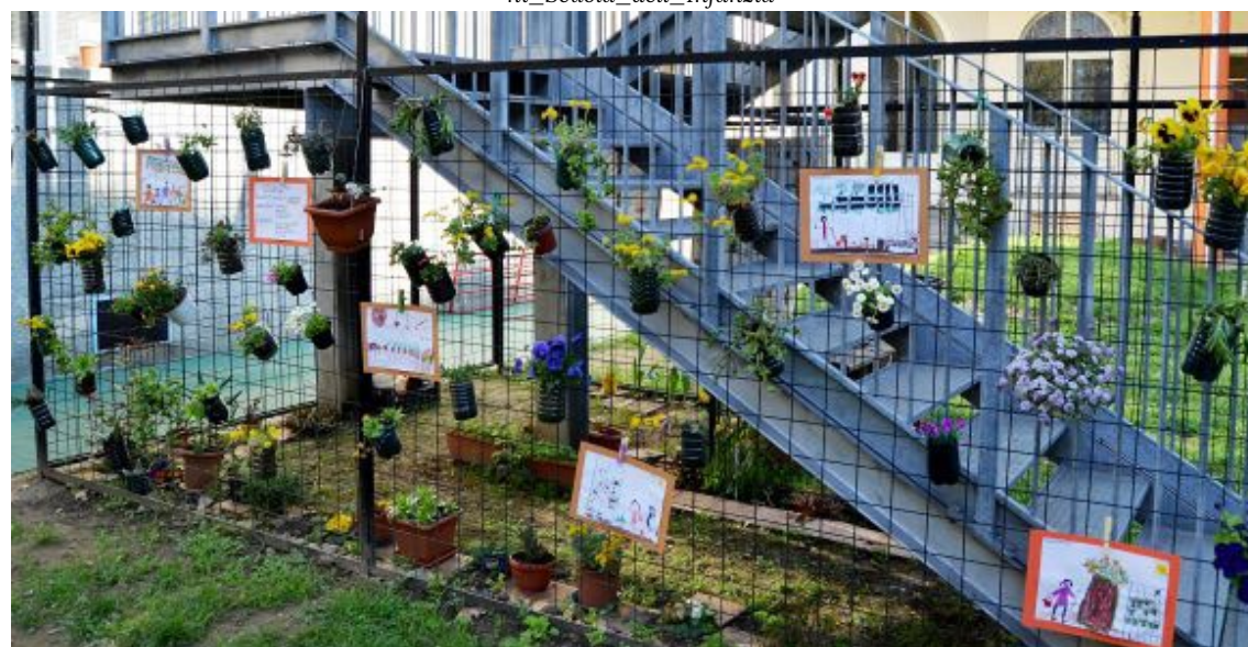
Figura 201: Uso della rete intorno alla scala d'emergenza come giardino verticale nel cortile della scuola dell'infanzia comunale Principessa di Piemonte, Torino (IT); fonte: www.youreporter.it/gallerie/Inaugurato_Cortile_e_Giardini_Scuola_dell_Infanzia
