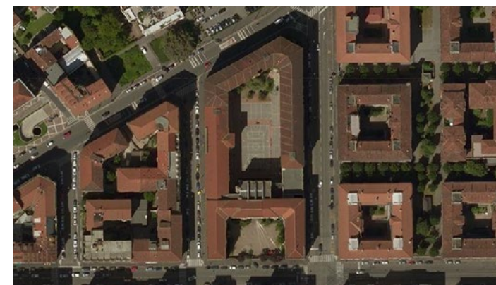
Figura 1: Esempio di edificio scolastico a corte interna, Istituto Comprensivo Quinto Di Vona, Milano; fonte: Bing Maps
