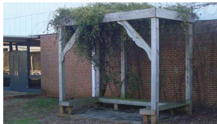
Figura 164: Elemento di schermatura solare dove vengono fatte crescere piante rampicanti, in modo da fornire una occasione di osservazione interessante; fonte: BRODA, 2011
