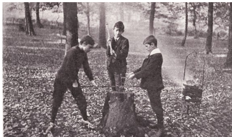
Figura 21: Lavoro di forgiatura, Uffculme Open Air School, Birmingham (UK); fonte: BROUGHTON, 1914
