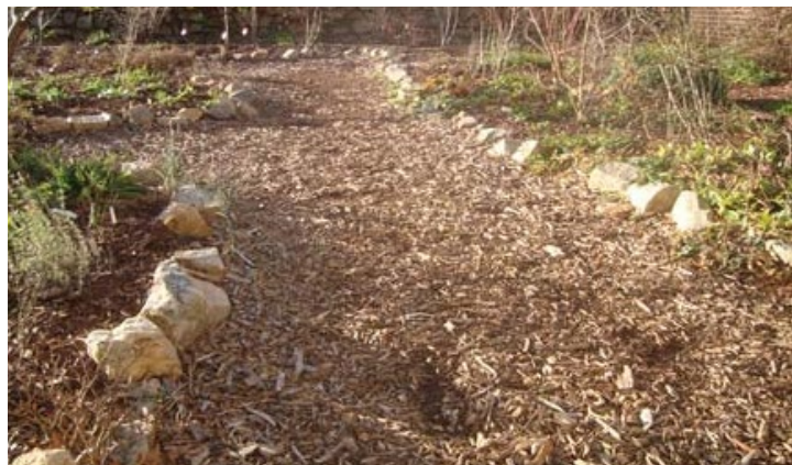
Figura 157: Camminamento realizzato con truciolo di legno, delineato con pietre; fonte: BRODA, 2011
