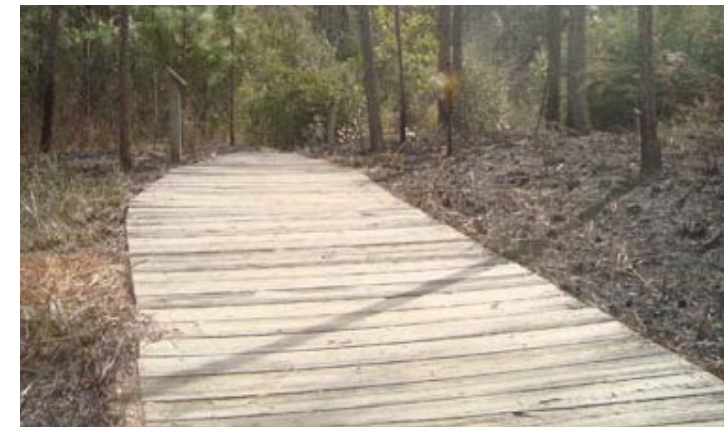
Figura 160: Esempio di percorso pavimentato con assi di legno; fonte: BRODA, 2011
