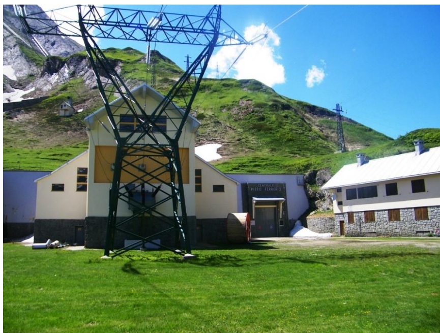
Figura 5-1 centrale "Piero Ferrerio"
