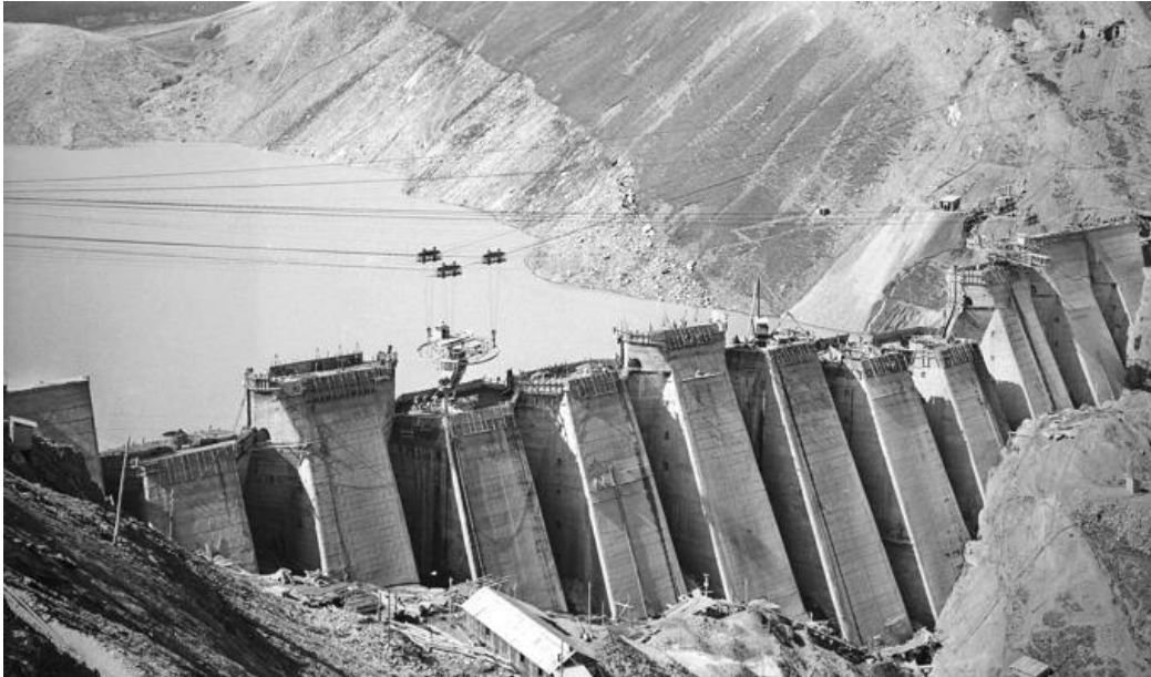
Figura 2-9 realizzazione diga Sabbione
