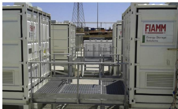
Figura 2.14 Installazione di batterie NaNiCl 2 a Codrongianos
