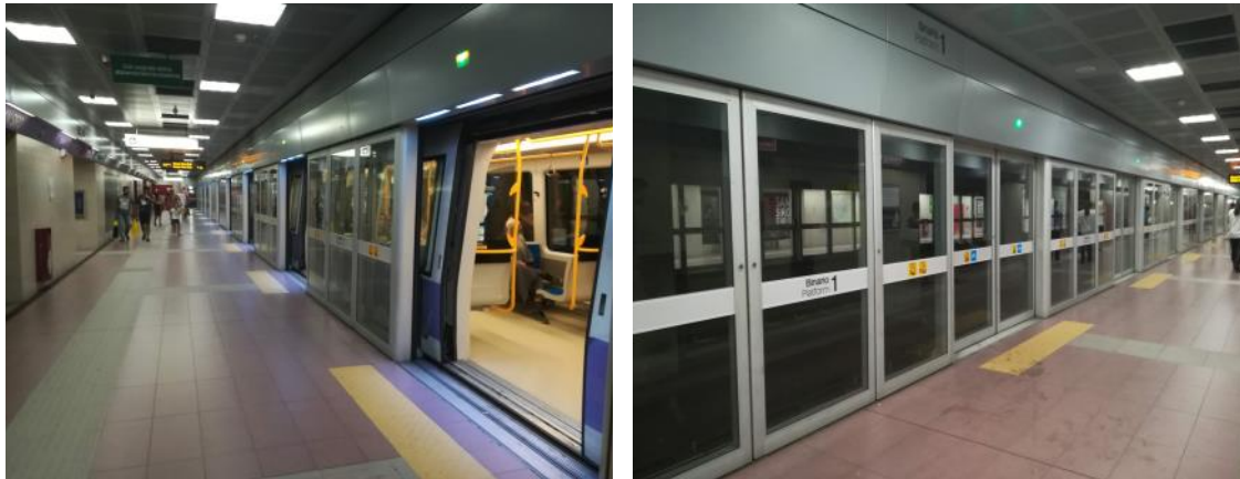
Figura 2.17 – Stazione metropolitana di Milano, Linea 5. Porte di banchina.
