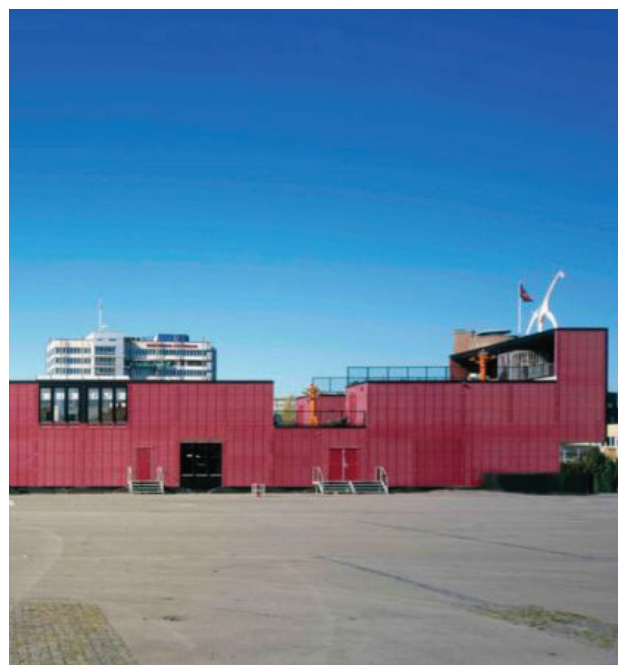
Figura 10.177: Villa Zebra a Rotterdam; Fonte: http://xxarchitekten.nl/ ;
