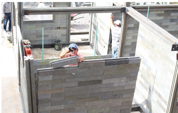
Figura 10.9: La realizzazione di un edificio. I mattoni vengono incastrati tra di loro e ancorati a degli elementi verticali e orizzontali di giunzione in plastica riciclata; Fonte: https://www.archdaily.com.br/ ;
