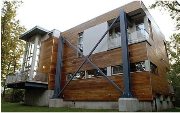
Figura 10.34: La struttura recuperata per la realizzazione del nuovo edificio è stata mantenuta volontariamente all'esterno per renderla visibile; Fonte: https://www.archdaily.com/ ;
