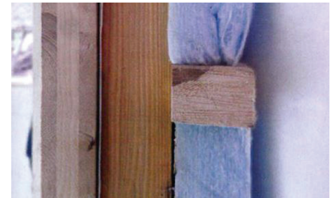
Figura 10.27: Strato di isolante riciclato da bottiglie PET; Fonte: Arketipo, 2013;
