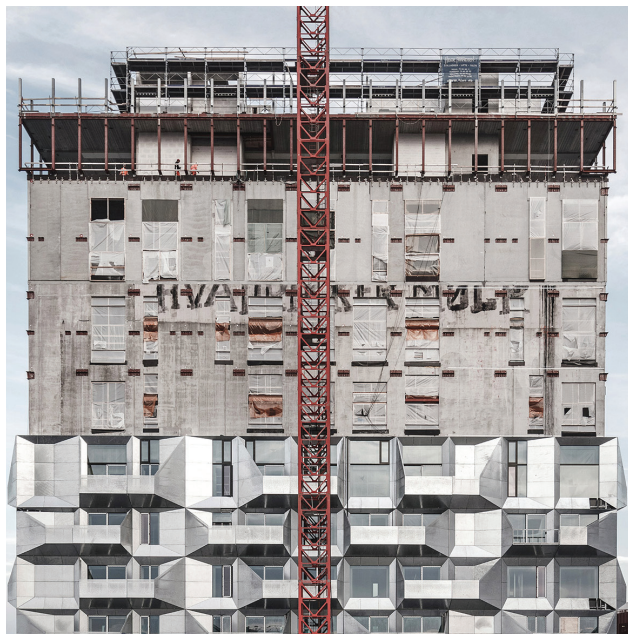
Figura 10.152: Il progetto ha previsto l'aggiunta di un nuovo piano sull'edificio esistente; Fonte: https://www.archdaily.com/ ;
