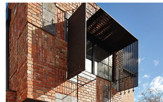
Figura 10.168: Le inferiate metalliche recuperate dalla parte di edificio demolito sono state riusate come schermature solari; Fonte: https://www.phooley.com.au/ ;
