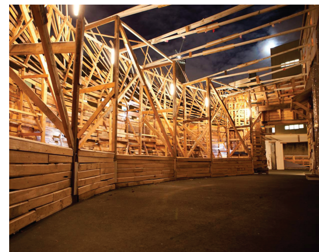
Figura 10.48: Vista dell'interno in cui si notano gli elementi di recupero; Fonte: http://www.koebberlingkaltwasser.de/ ;
