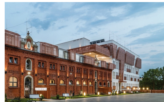
Figura 10.144: Il complesso rinnovato dopo l'intervento; Fonte: http://www.nanowoarchitekci.pl/ ;
