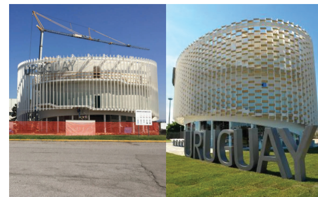
Figura 10.189: Il padiglione durante la ricostruzione e l'inaugurazione come ristorante a Origgio; Fonte: https://www.varesenews.it/ ;
