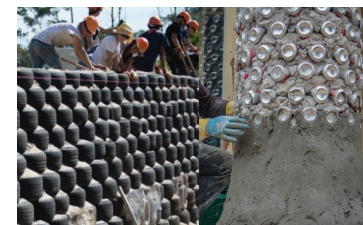
Figura 10.54: Realizzazione della struttura portante con pneumatici e realizzazione delle colonne in lattine di alluminio rivestite; Fonte: https://www.plataformaarquitectura.cl/ ;
