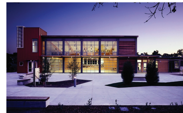
Figura 10.122: Vista frontale dell'edificio; Fonte: http://www.ehdd.com/ ;
