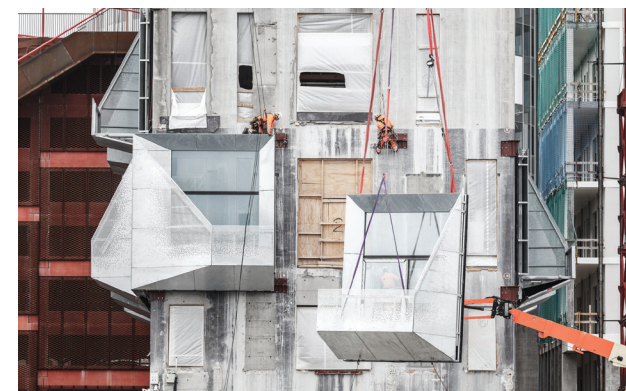
Figura 10.151: L'assemblaggio in sito degli elementi prefabbricati; Fonte: https://www.archdaily.com/ ;
