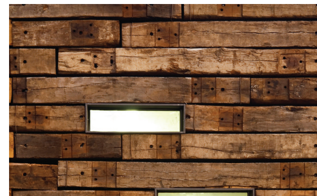
Figura 10.156: Dettaglio del rivestimento esterno realizzato con il recupero delle traversine dei binari dismessi; Fonte: https://www.archdaily.com/ ;
