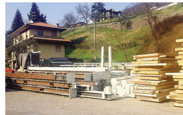
Figura 10.185: I materiali e gli elementi del padiglione trasportati a Bergamo per la ricostruzione; Fonte: https://www.ecodibergamo.it/ ;
