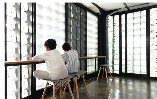
Figura 10.40: Vista dell'interno: le vaschette permettono il passaggio della luce naturale creando un'illuminazione confortevole; Fonte: https://www.archdaily.com/ ;
