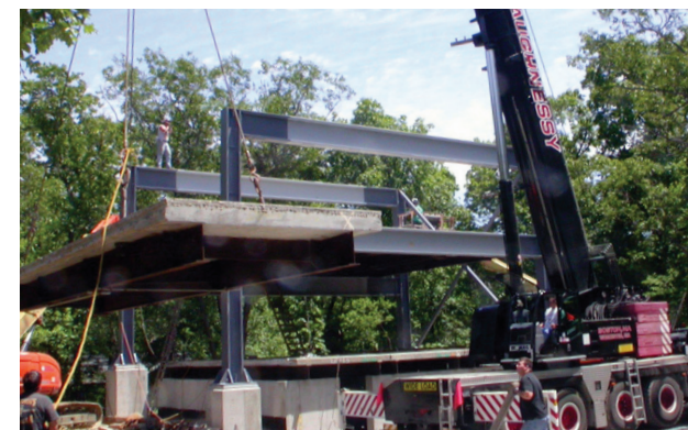
Figura 10.33: Assemblaggio in cantiere degli elementi recuperati; Fonte: https://www.archdaily.com/ ;
