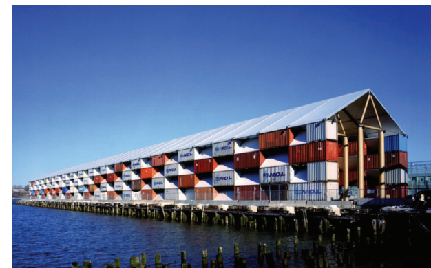
Figura 10.190: Vista complessiva dell'edificio (NY); Fonte: https://www.lib.ncsu.edu/ ;
