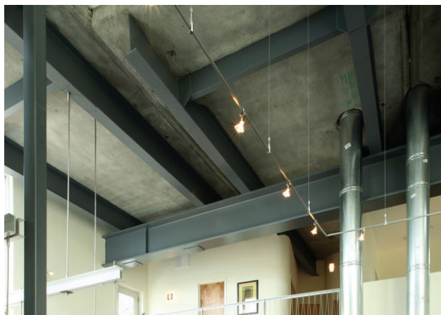
Figura 12.3: Elementi in calcestruzzo e acciaio provenienti dallo smantellamento dell'autostrada Big Dig, Big Dig House, US, 2008; Fonte: https://www.archdaily.com/ ;
