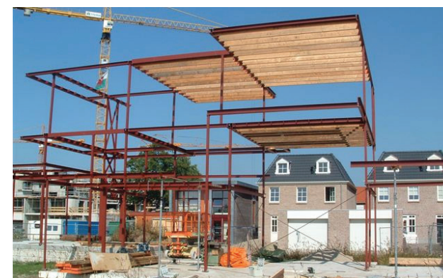
Figura 10.82: La struttura portante, ad eccezione delle fondazioni, è stata completamente realizzata con elementi di recupero; Fonte: http://www.devoti.it/ ;
