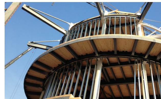
Figura 10.188: La costruzione del padiglione: i solai sono realizzati a secco in acciaio e XLAM per permettere la decostruzione totale; Fonte: https://www.ingegneri.cc/ ;
