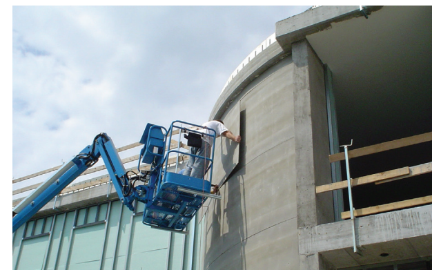
Figura 10.16: L'83% dei pannelli di tamponamento in legno-cemento sono ottenuti da scarti di segherie; Fonte: http://www.savnoservizi.it/ ;
