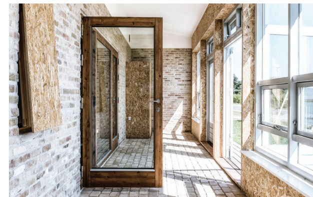
Figura 10.77: La parete in mattoni è realizzata con elementi di recupero così come gli infissi sono di riuso; Fonte: https://www.archdaily.com/ ;
