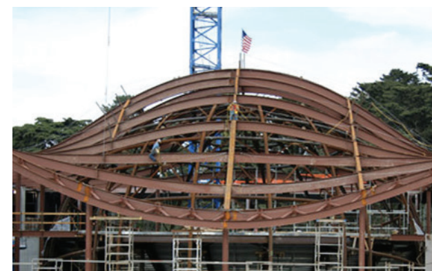
Figura 10.101: Gli elementi della struttura portante in acciaio sono realizzati con contenuto di riciclato; Fonte: http://www.notcot.com/ ;
