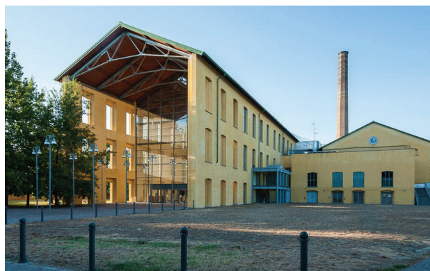
Figura 10.128: Vista complessiva dell'edificio; Fonte: http://www.archidiap.com/ ;
