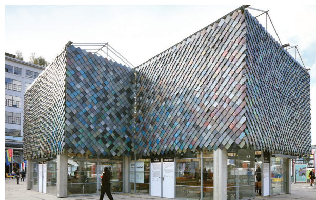
Figura 10.22: Vista complessiva dell'edificio;
