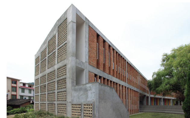
Figura 10.114: Vista complessiva dell'edificio; Fonte: https://divisare.com/ ;
