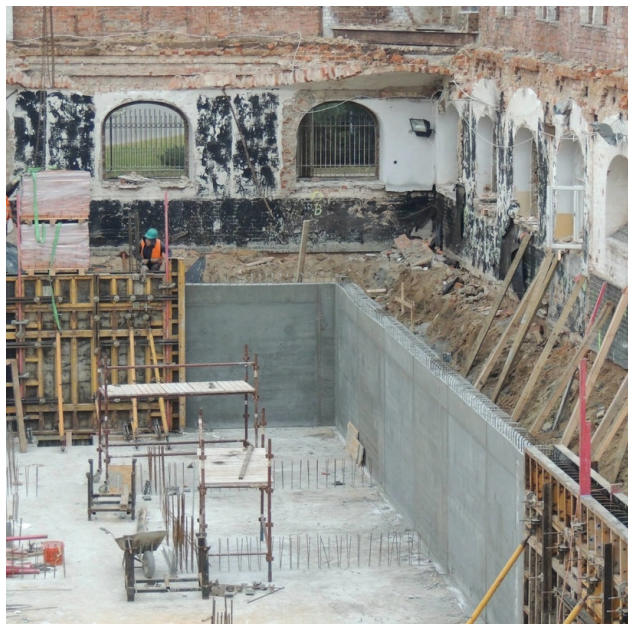
Figura 10.146: La realizzazione del nuovo piano interrato realizzato sull'edificio esistente; Fonte: http://www.nanowoarchitekci.pl/ ;
