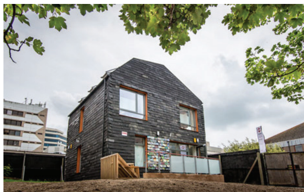
Figura 10.92: Vista dell'edificio; Fonte: https://www.dezeen.com/ ;
