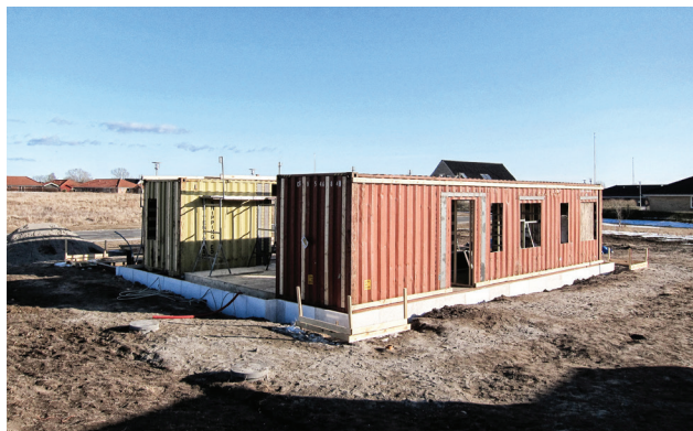
Figura 10.78: La struttura portante è realizzata con due container navali dismessi; Fonte: https://www.archdaily.com/ ;
