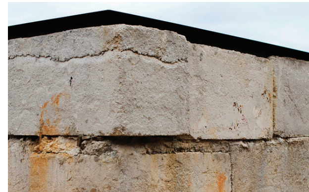
Figura 10.13: I blocchi di calcestruzzo con contenuto di riciclato; Fonte: http://archdaily.com/ ;
