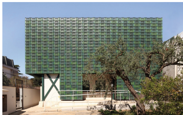
Figura 10.162: Vista del nuovo ingresso realizzato con cassette in plastica di recupero; Fonte: https://www.archdaily.com/ ;
