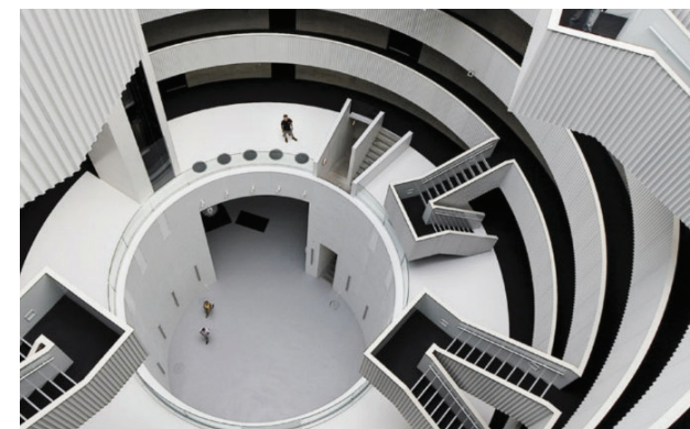
Figura 10.140: Vista dell'interno del silo dopo l'intervento; Fonte: https://www.mvrdiv.nl/ ;
