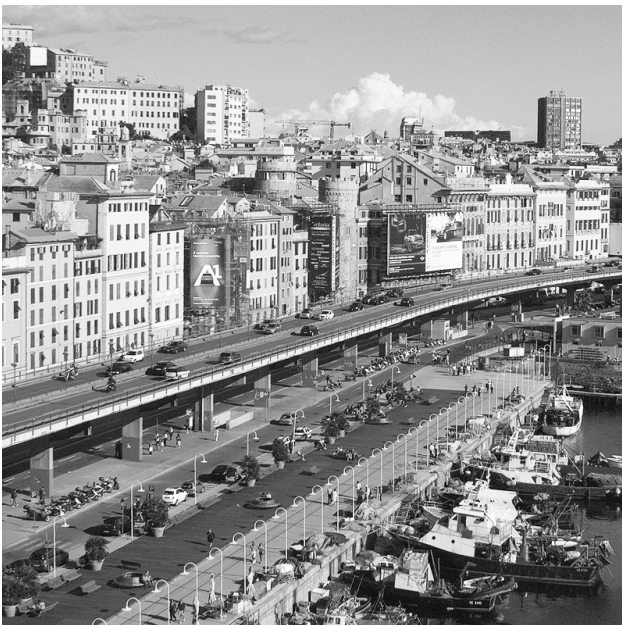
In alto la sopraelevata di marmo, progetto dell'Ingegnere Gardella del 1880 In basso la sopraelevata nel porto antico
