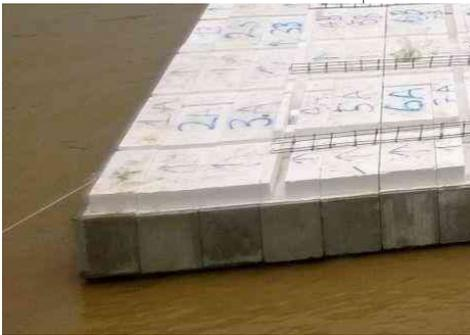
Sistema galleggiante in cemento nel progetto di MFS III X3
