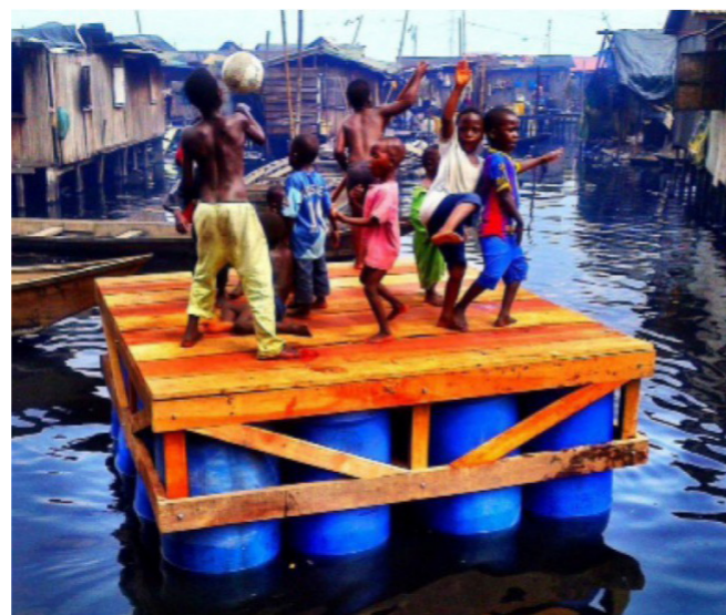
Fig. 5.4.19 Foto Makoko School: piattaforma di barili flottanti
