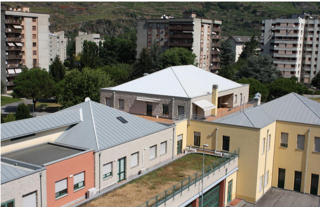
Vista della casa del comandante, unico locale al secondo piano
