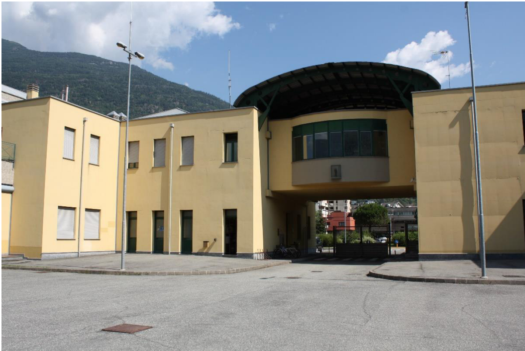
Vista dei laboratori, il cui ingresso avviene dall'esterno
