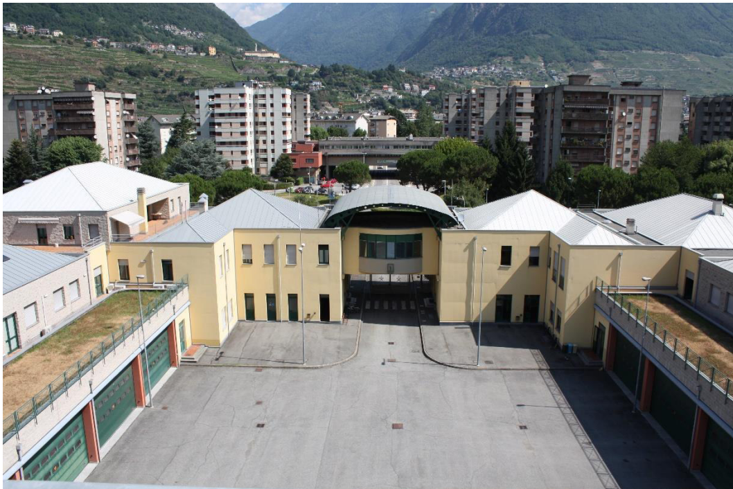
Vista dello spazio di manovra interno della caserma
