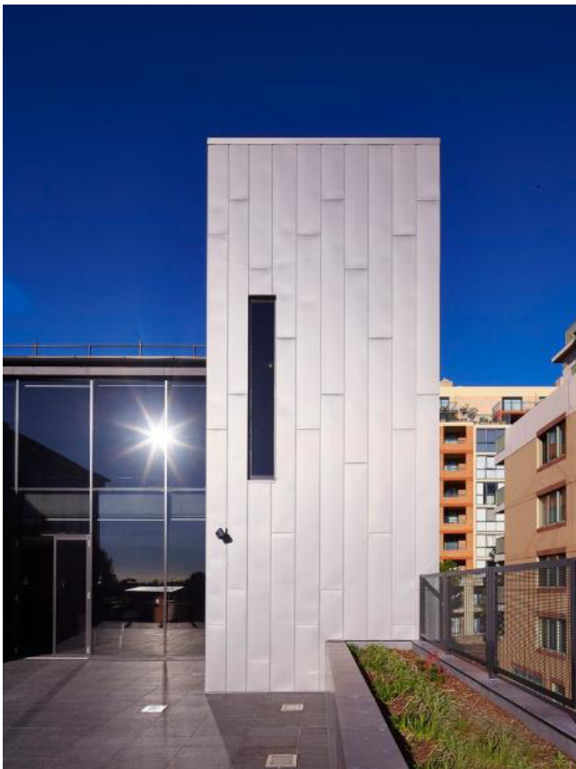
Vista del vano scala rivestito in zinco
