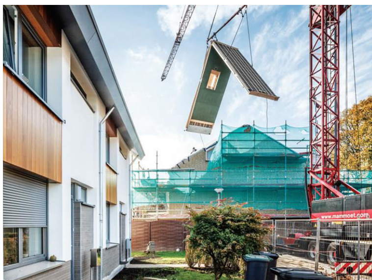
Posa di una copertura prefabbricata in un cantiere inglese
