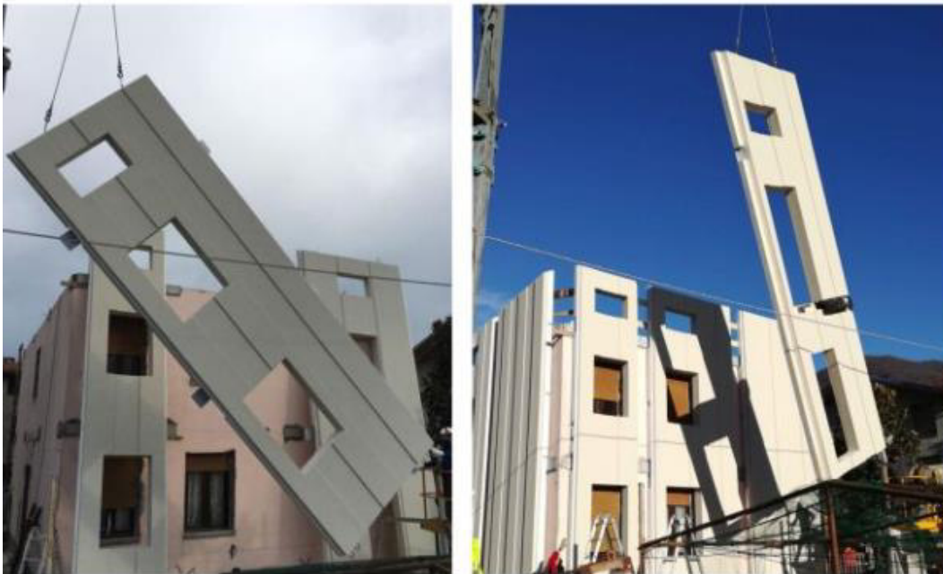
Fase di posizionamento dei pannelli sull'edificio da riqualificare a Pizzo
