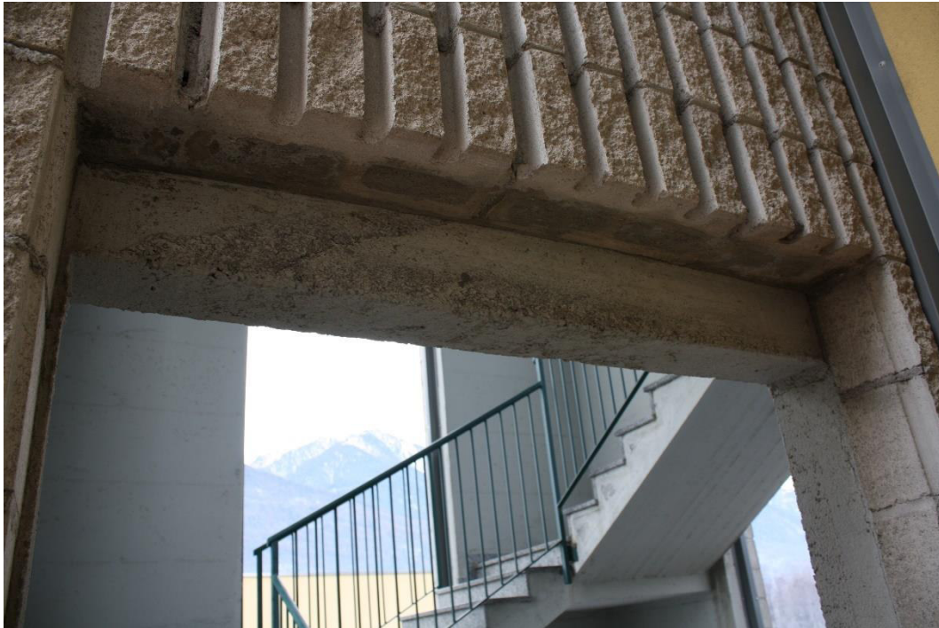
Vista della muratura di una delle torrette delle scale
