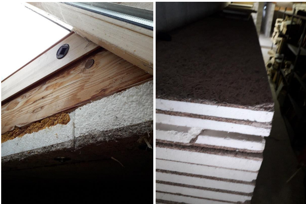
Pannelli coibentati in polistirene espanso e fibra di legno mineralizzata usati per le coperture a falde
