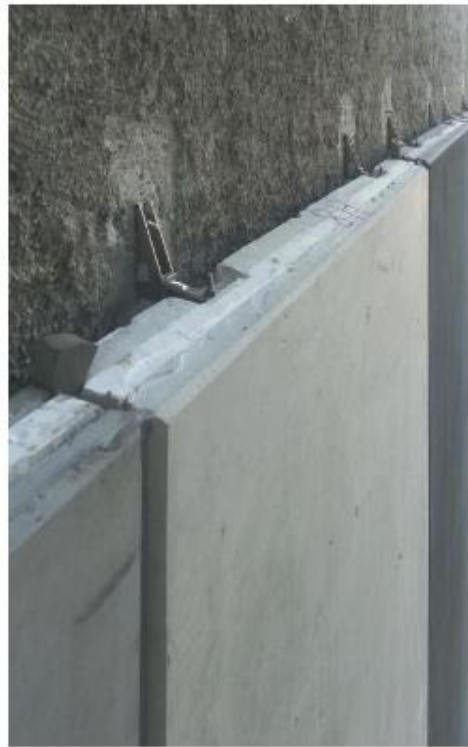
Fissaggio dei pannelli all'edificio
