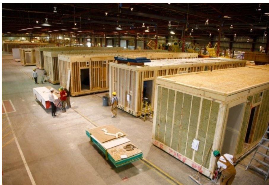
Figura 2-7: Moduli prefabbricati in legno
