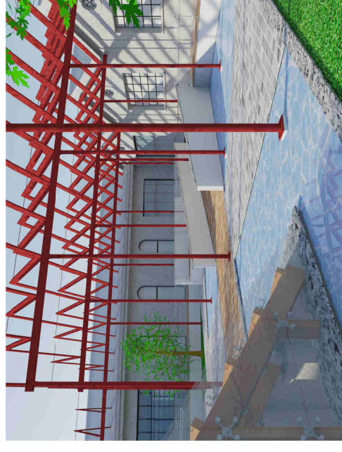
4 e 5 - Viste dello spazio tra il Complesso Edilizio E e F dove si nota la differenza di quota tra i due e la struttura in metallo rosso a ricordo di alcuni edifici demoliti.
