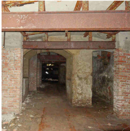
59. Vista dell'interrato con le opere di consolidamento.
