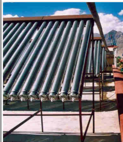
138. Esempio di applicazione di collettori a tubi
