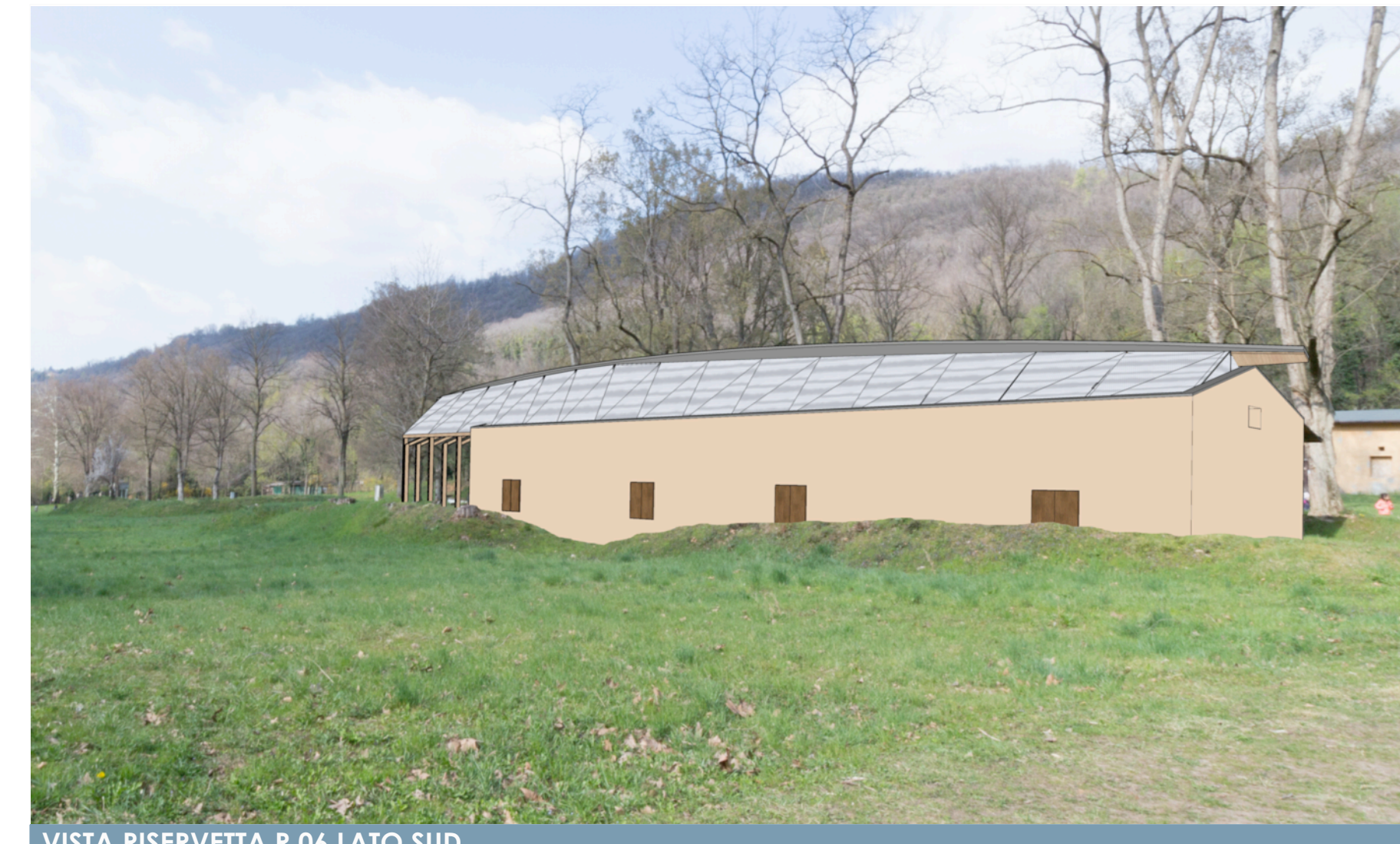
VISTA RISERVETTA R.06 LATO SUD
