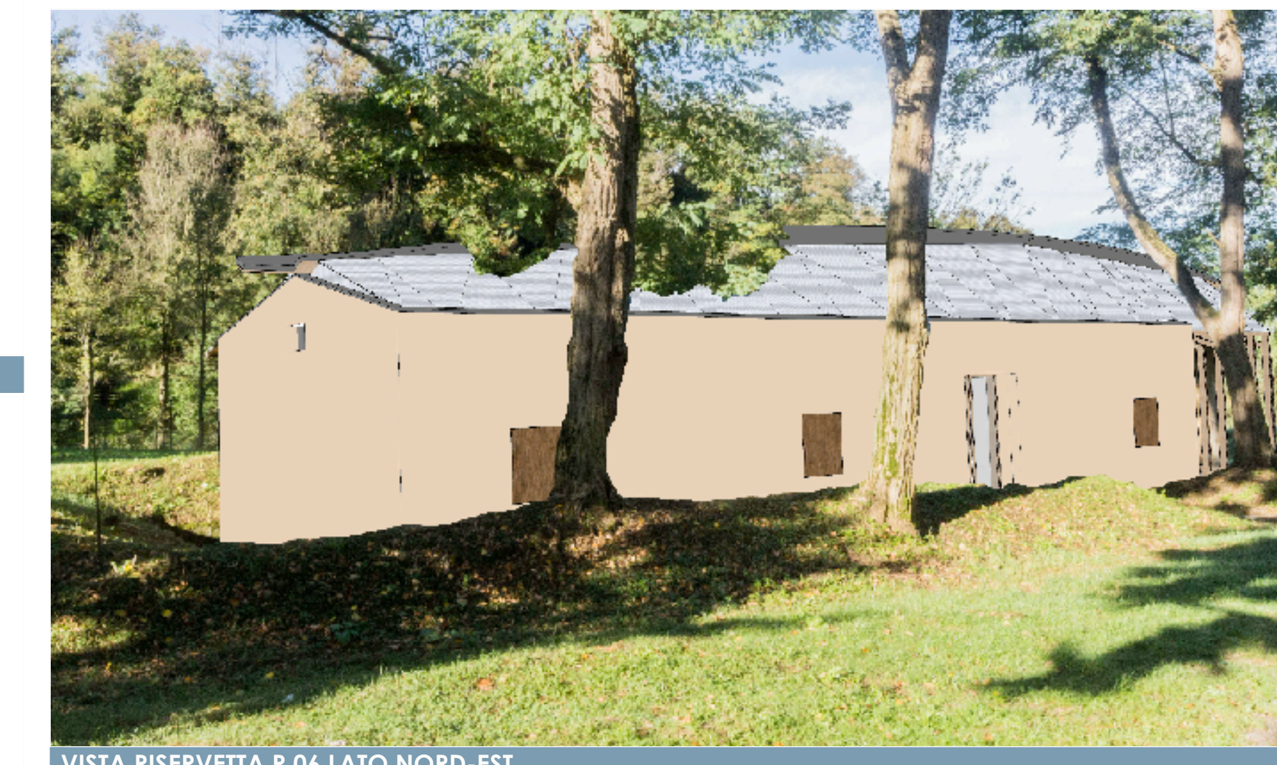
VISTA RISERVETTA R.06 LATO NORD-EST
