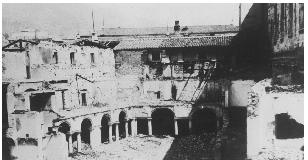
Caserma Gnutti, Vista della corte interna dopo il bombardamento del 2 aprile 1945
