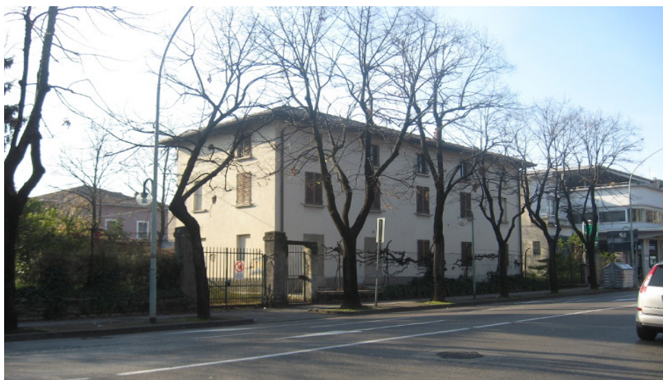
Colombaia di via Diaz, Vista lato nord
