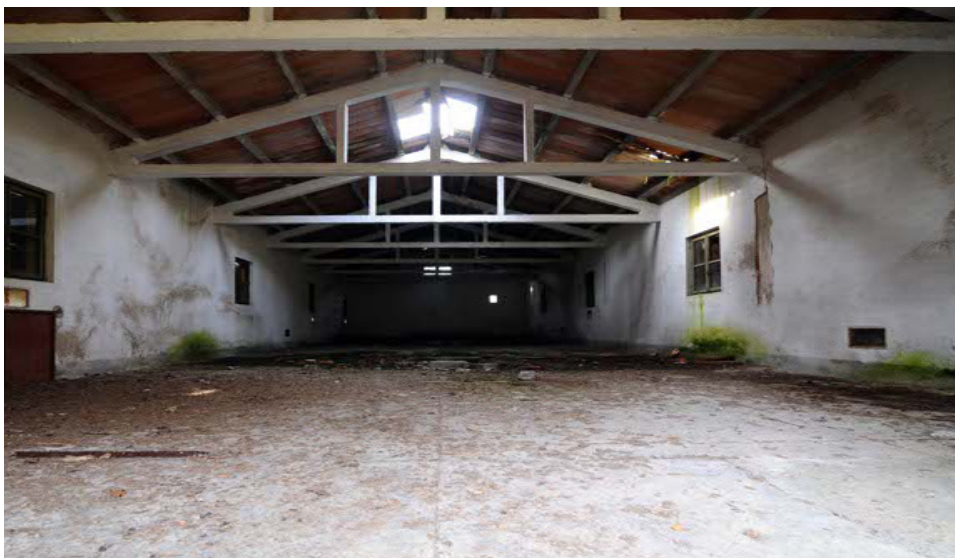
Vista interna delle riserve: tipologia con capriate prefabbricate
