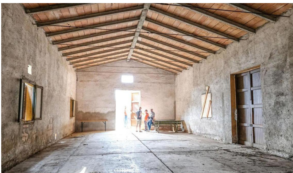
Vista interna delle riserve: tipologia con tiranti in ferro
