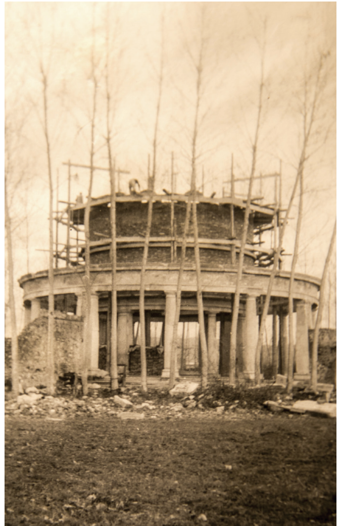
Fig. 2.16 - Lavori di ricostruzione del tempietto centrale del lazzaretto, compiuta da maggio a ottobre del 1958.
