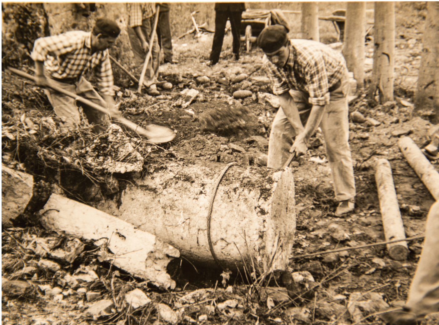
Fig. 2.17 - Lavori di ricostruzione del tempietto centrale del lazzaretto, compiuta da maggio a ottobre del 1958. Nella foto si documentano le attività di anastilosi, con ricollocazione degli elementi architettonici crollati a causa delle esplosioni.
