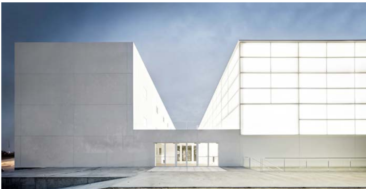
17 - Vista dell'ingresso Multisport pavilion UFV
