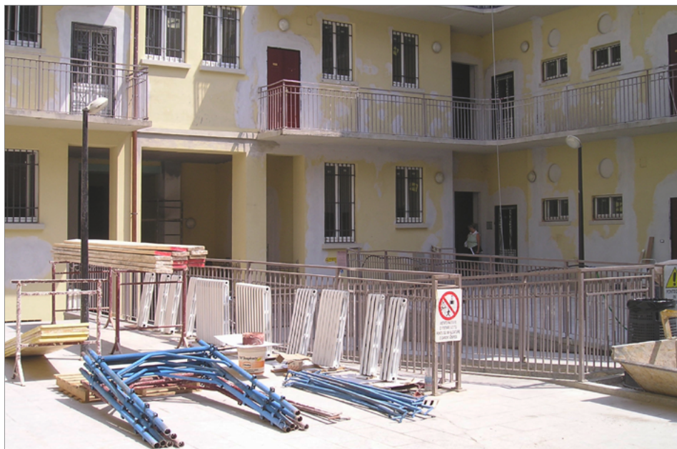
Fig. 2.6 I lavori all'interno della corte di via Palmieri 22 Fonte: Dar=casa
