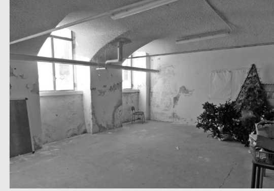
Spazi deposito, piano interrato via Venini
