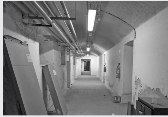
Corridoio, piano interrato via Venini
