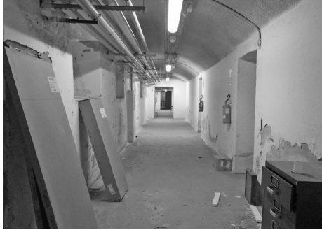
Fig. 65. Corridoio, piano interrato via Venini
