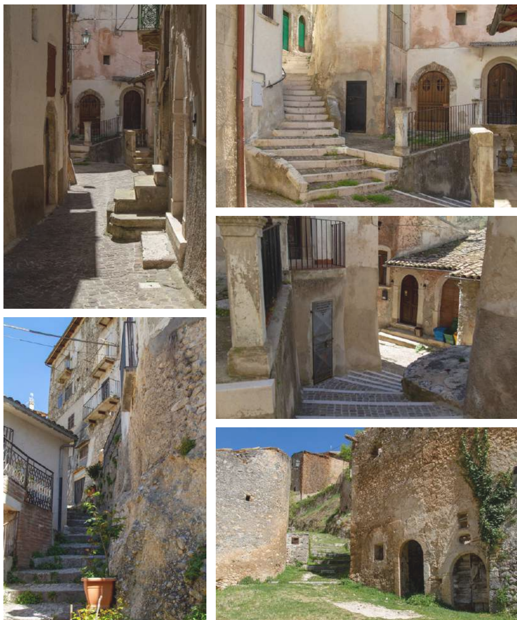
Fig. 6.4 Fotografie della viabilità allo stato di fatto (sopra)
