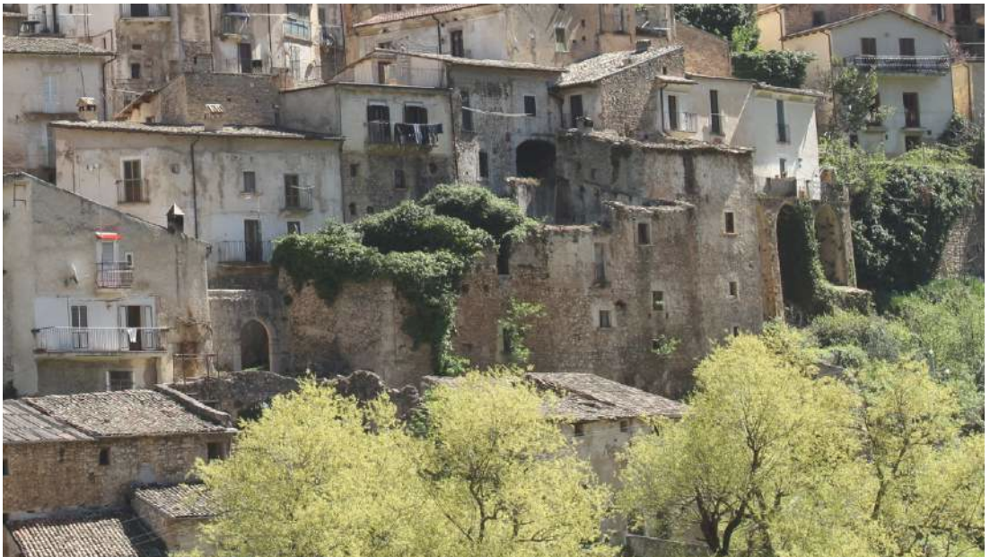
Sotto: Fig. 8.26 Fotografia dello stato di fatto dell'edificio M5 (fronte ovest)
