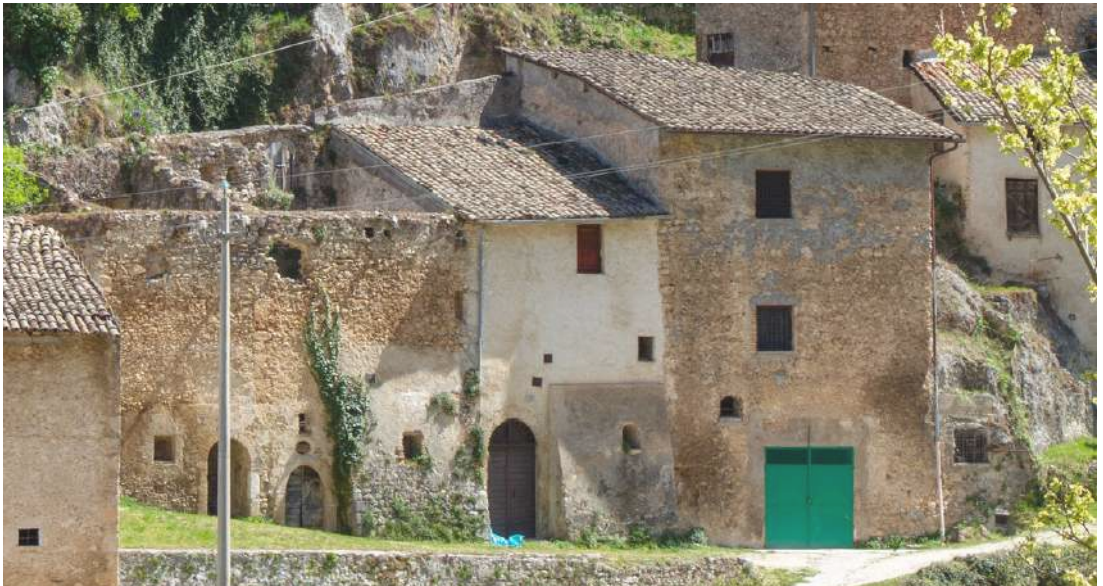
Sotto: Fig. 8.7 Fotografia dello stato di fatto dell'edificio S2 del fronte ovest
