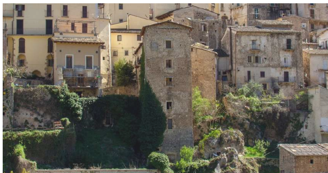
Sotto: Fig. 8.19 Fotografia dello stato di fatto dell'edificio M3 (fronte ovest)
