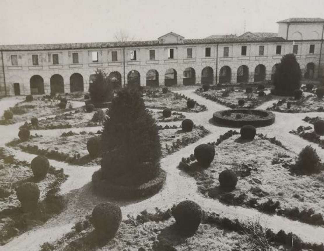
Figure 11: Giardino dei Semplici before Restoration
