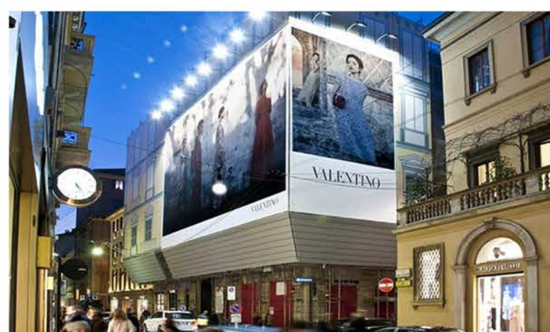
Importanza economica della pubblicità sui ponteggi durante i cantieri edili
