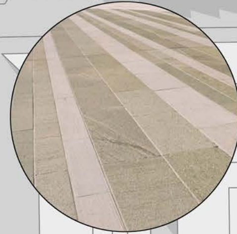
Pavimentazione in lastroni di pietra della nuova piazza aggregativa di Loreto.
