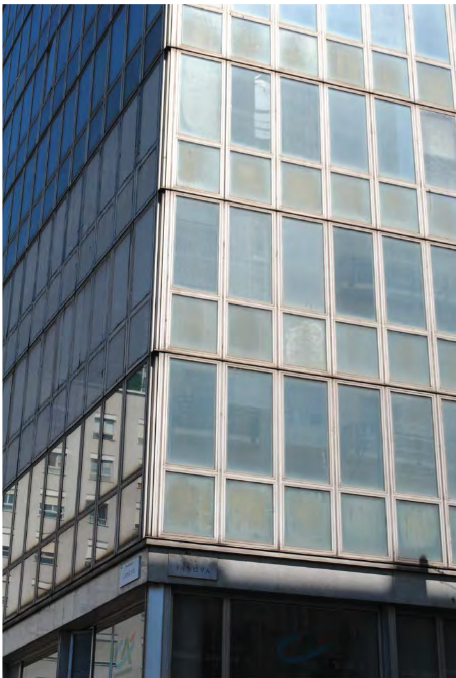
Figura 130: Particolare d'angolo del curtain-wall del Palazzo del Fuoco nel 2016
