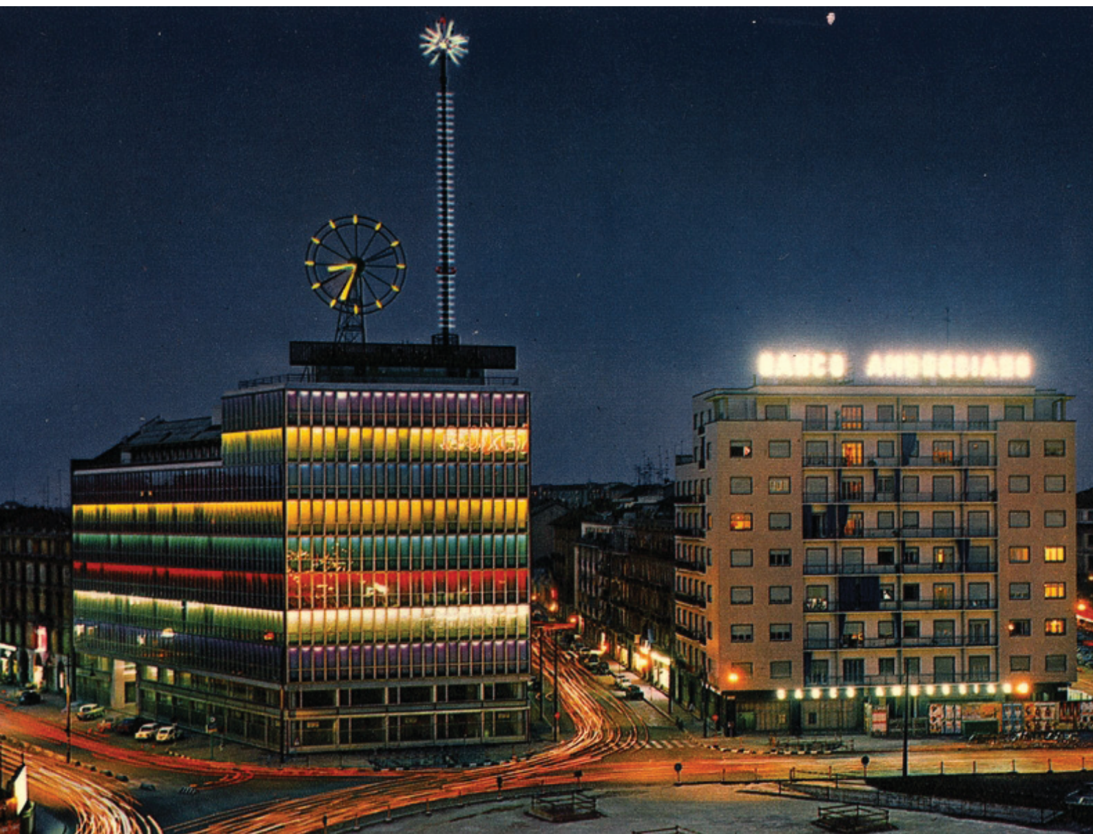
Figura 15: Palazzo del Fuoco 1961
