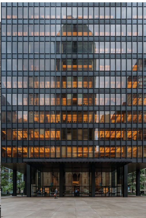
Figura 17: Facciata del Seagram Building
