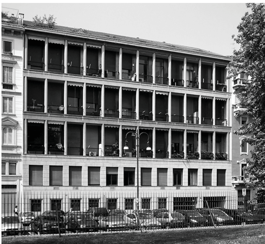
Figura 102: Edificio per abitazioni in via Filippino degli Organi
