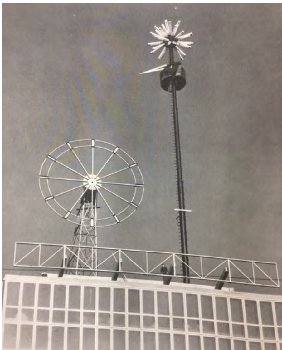
Figura 133: Il coronamento del prospetto del Palazzo del Fuoco nel 1970
