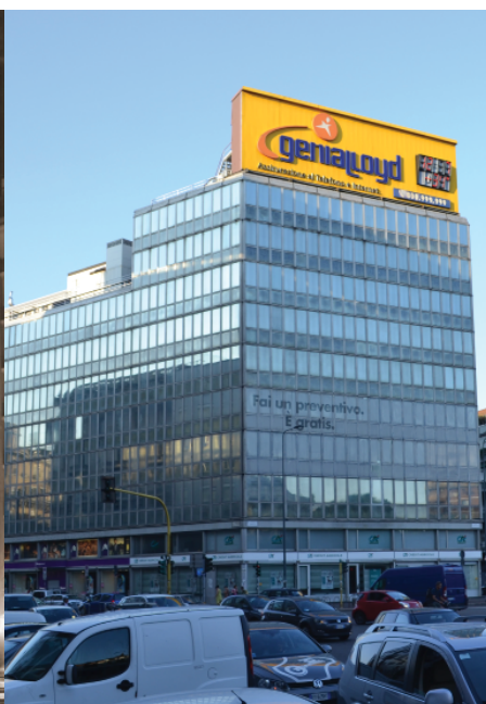
Figura 21: Palazzo del Fuoco oggi
