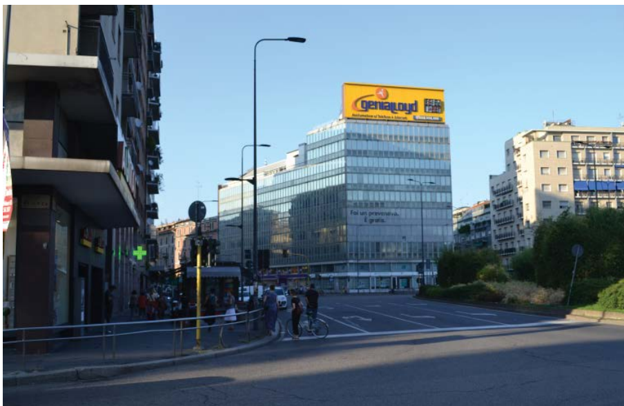
Figura 56: Palazzo del Fuoco oggi
