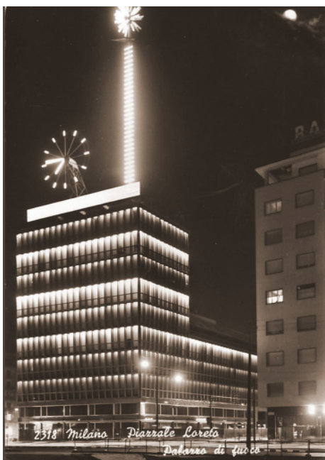
Figura 20: Palazzo del Fuoco 1961
