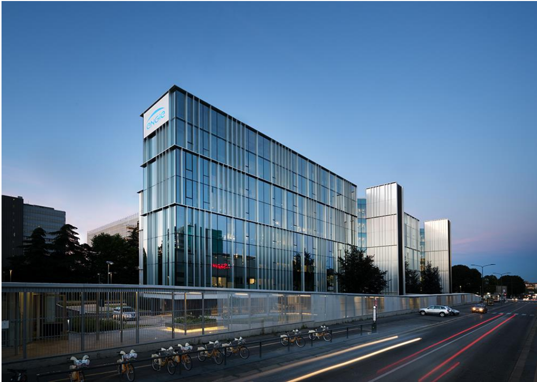
Figura 38. L'immobile dopo l'intervento di riqualificazione 57
