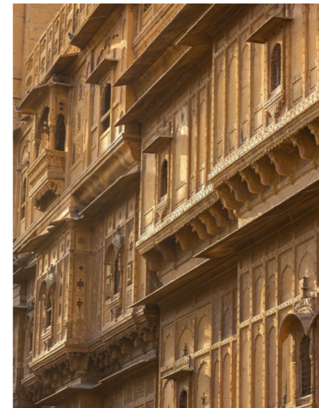
Fig.78 Facciata di una haveli fonte www.maison-monde.com
