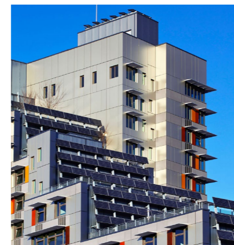
Fig.117 Pannelli solari integrati all'edificio fonte www.grimshaw.global
