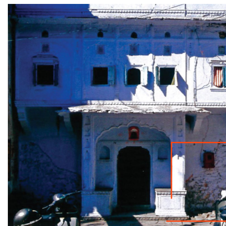
Fig.83 Facciata di una haveli con elementi dell'architettura tradizionale fonte BORIN A. CATALAA F. PAPILLAUT R. Jaipur, ville nouvelle du XVIIIème siècle au Rajasthan.
