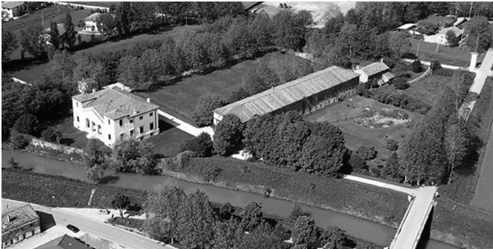
28. Veduta aerea di villa Pisani, opera di Palladio a Lonigo (VI)
