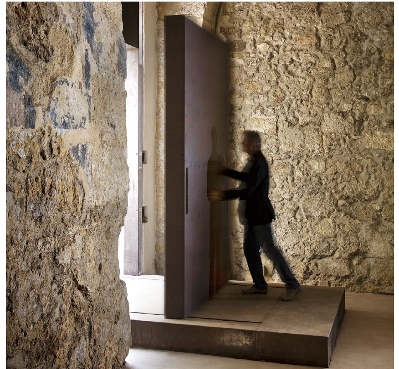
Fig.15 Portale mobile in acciaio corten nella Basilica paleocristiana di San Paolo a Siracusa, progetto di Emanuele Fidone Corten steel mobile portal in the early Christian Basilica of San Paolo in Syracuse, designed by Emanuele Fidone
