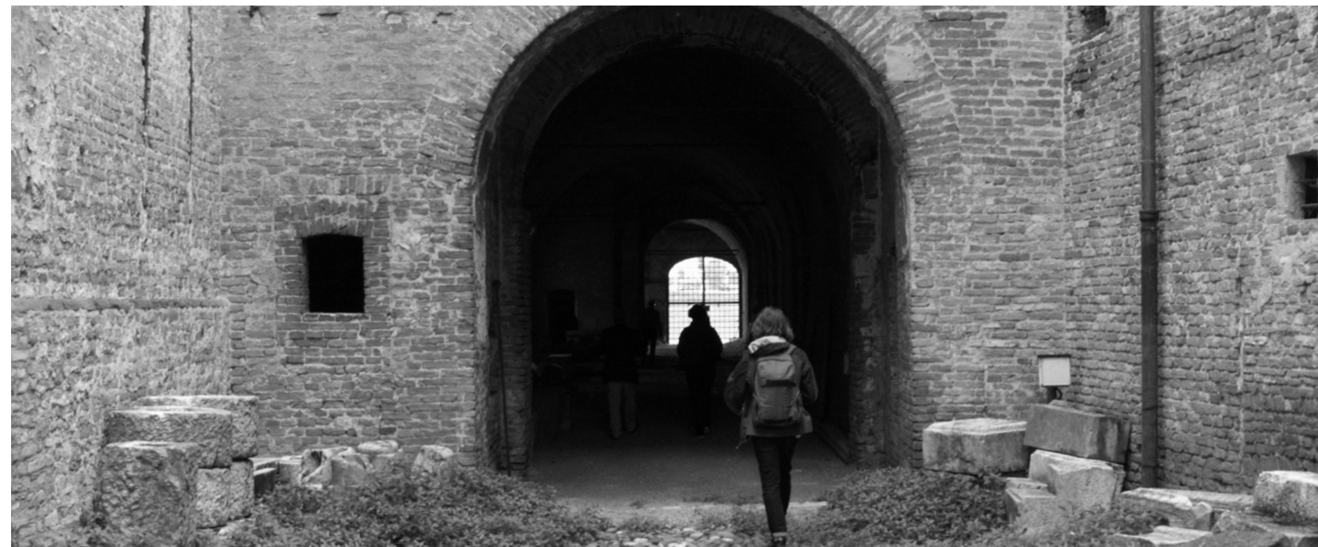
Fig.8 (Sopra) Strada di accesso da Piazza Santa Barbara Access road from Piazza Santa Barbara
