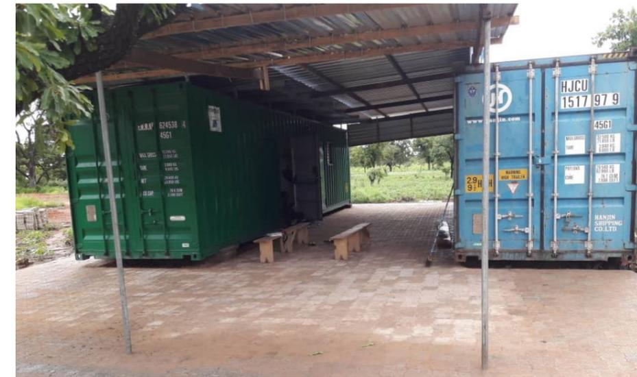
Completamento tettoia e posa della pavimentazione tra i container
