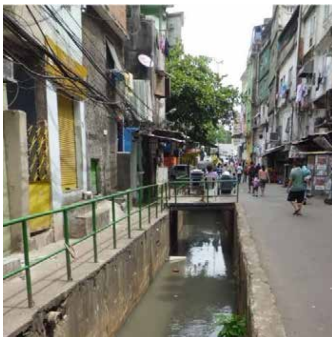
Figure 3.3.25 Canal do Valão. Source: CONEN, 2012
