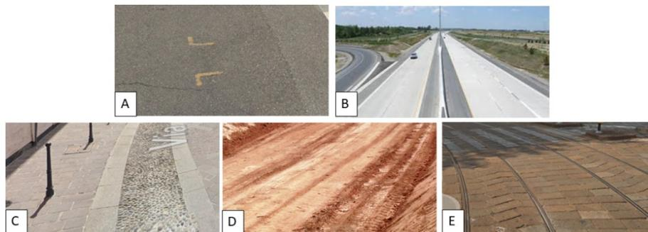
Figura 37: a) pavimentazione in conglomerato bituminoso, categoria PAVIMENTATA, b) pavimentazione in calcestruzzo, categoria PAIMENTATA, c) esempio di categoria AD ELEMENTI, d) strada sterrata, categoria NON PAVIMENTATA, e) esempio di categoria CON ROTATIE. (fonte a,c,e Google Maps, b (43), d (44)).
