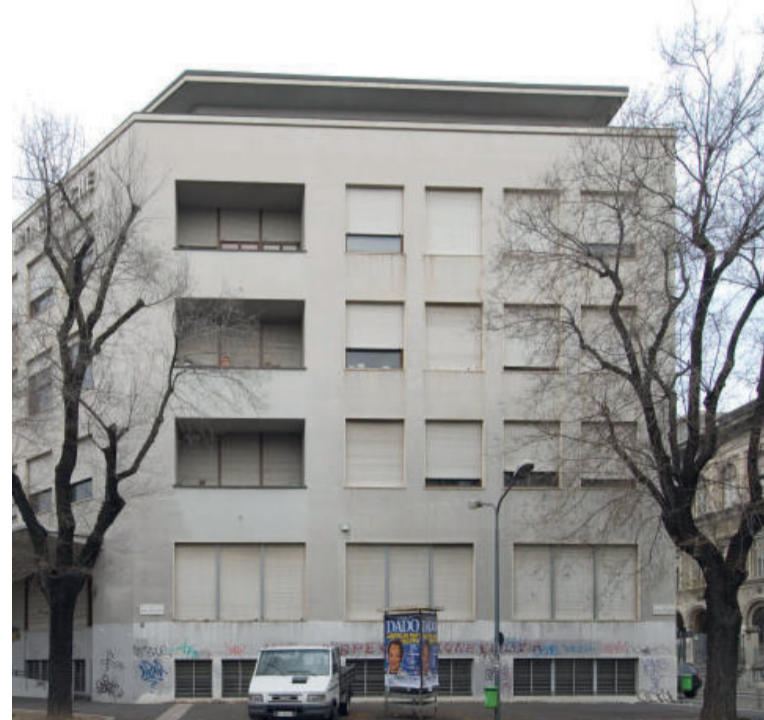
F4: Vista facciata sud, su via Sandro Botticelli
