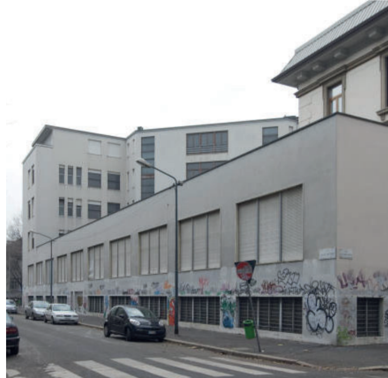
F3: Vista facciata su via Cesare Saldini
