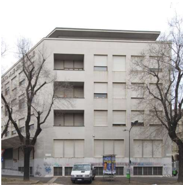
F4: Vista facciata sud, su via Sandro Botticelli
