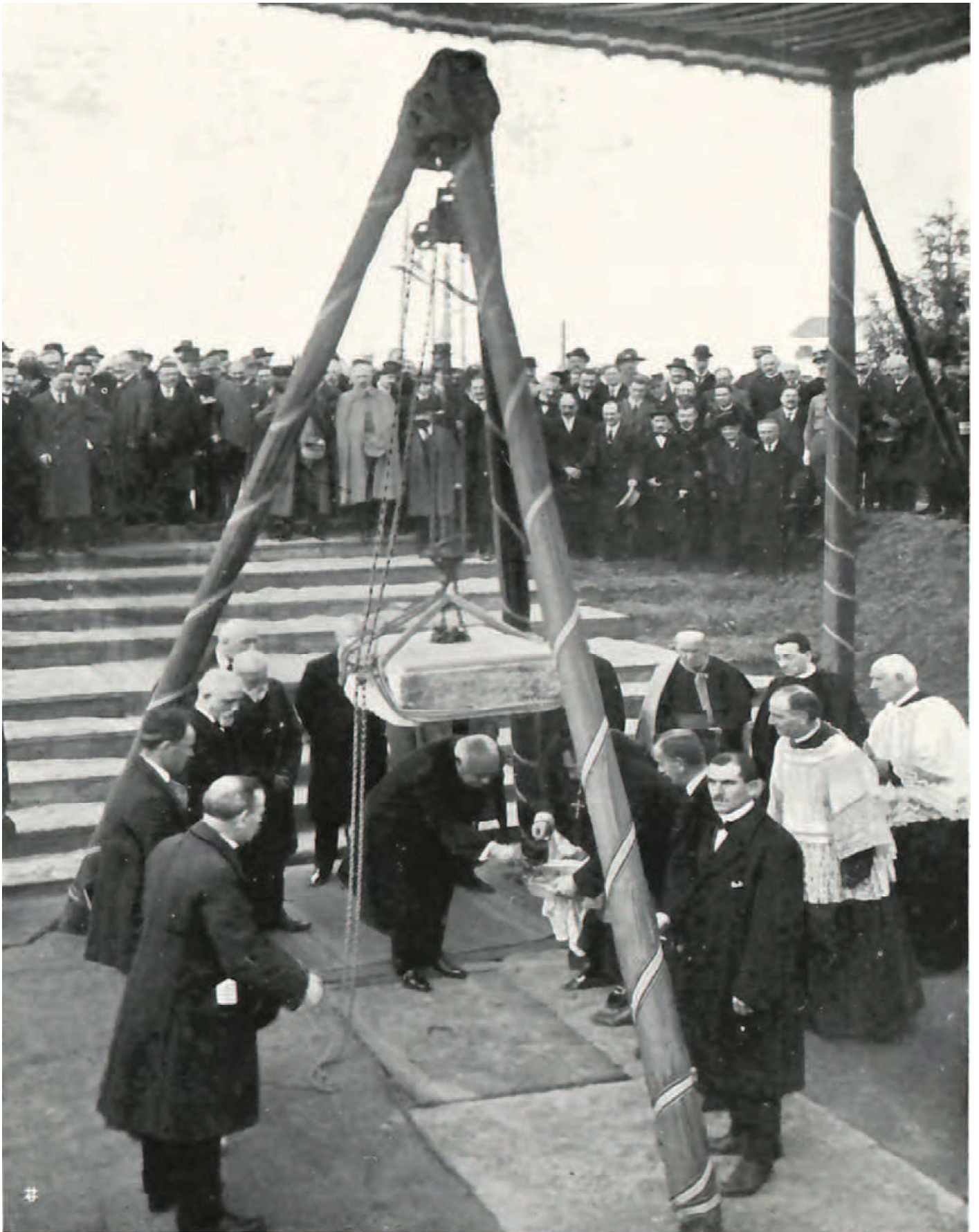
Figura 2.3_Cerimonia di posa della prima pietra, 1915
