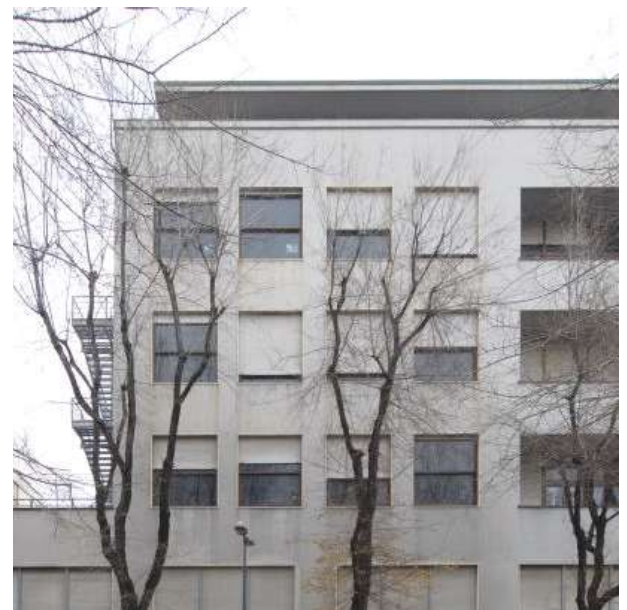
F5: Vista parziale facciata est, su via Cesare Colombo
