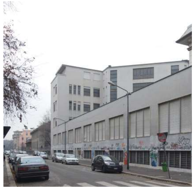
F3: Vista facciata su via Cesare Saldini
