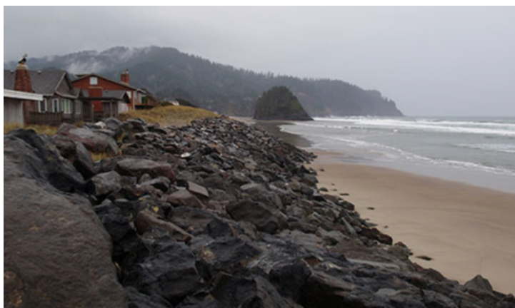
Figura 7 – esempi di difesa costiera aderente – (www.oregonstate.edu 2019)
