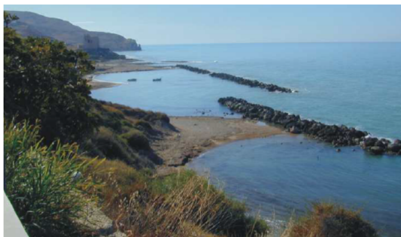
Figura 9 - Spiaggia protetta con frangiflutti distaccati emersi - (www.meteoweb.eu 2016)
