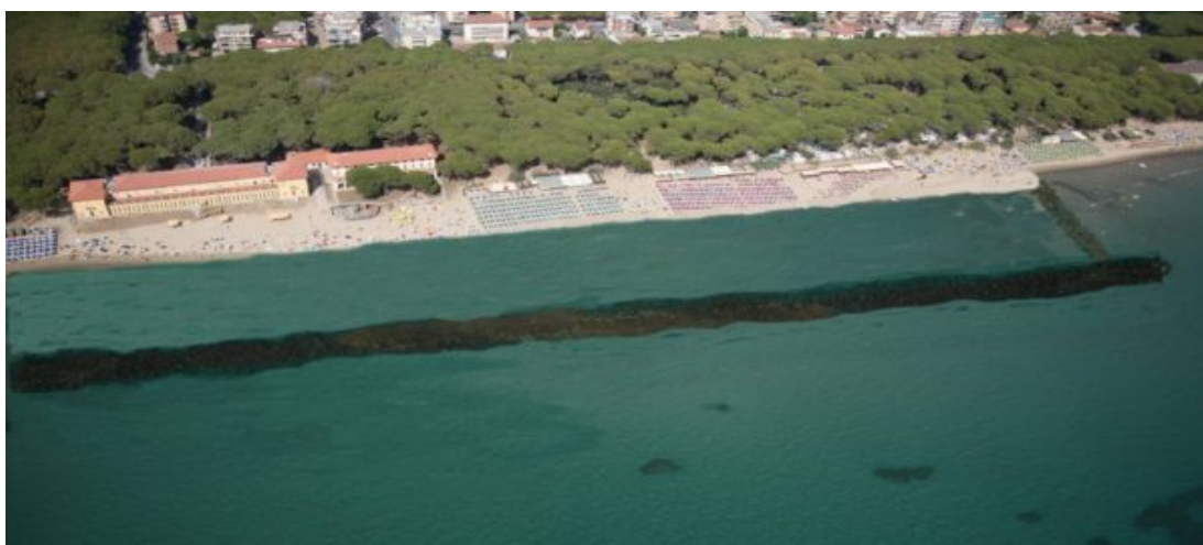
Figura 11 - Esempio di applicazione di barriera frangiflutti sommersa a Follonica - (www.grossetonotizie.it 2013)
