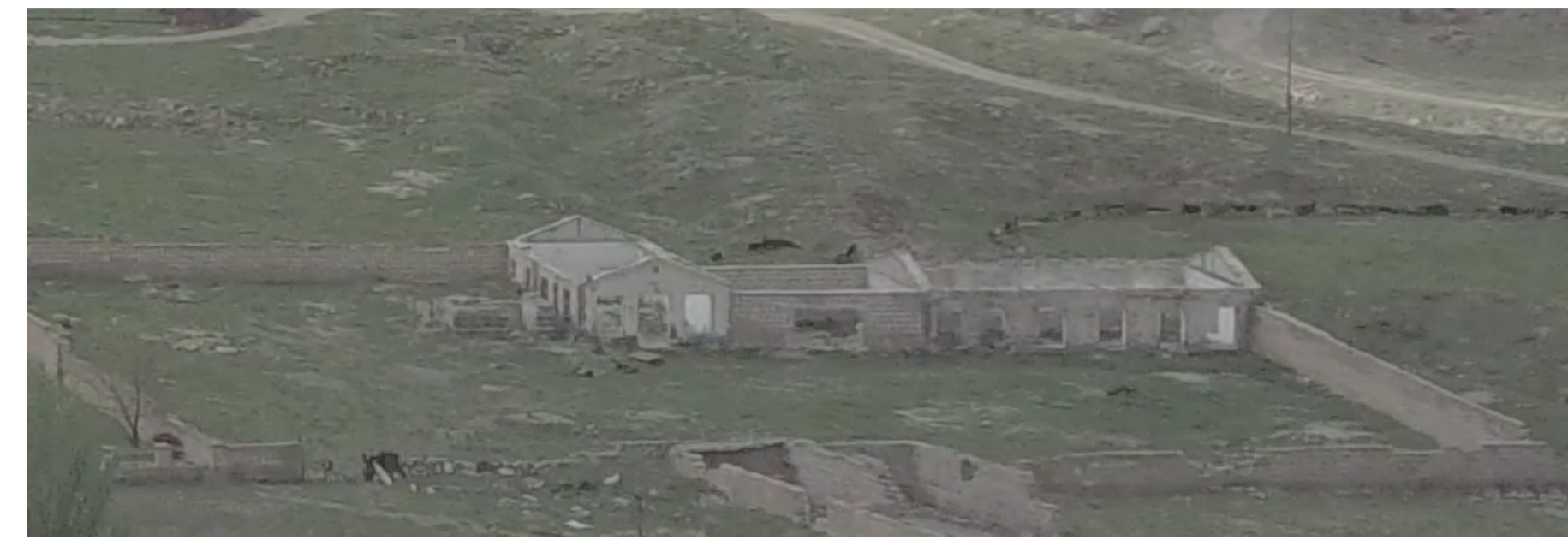
Stato di fatto dell'ex-Magazzino
