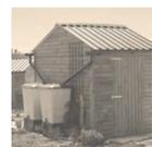
installazione di sistemi di recupero di acqua piovana negli edifici del villaggio, che permettono di avere una scorta rinnovabile d'acqua in caso di malfunzionamento del sistema idrico del villaggio.
