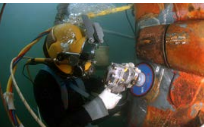
Fig. 19: subacqueo professionista con una comunicazione "diver-to-surface" integrata nel casco a tenuta stagna.
