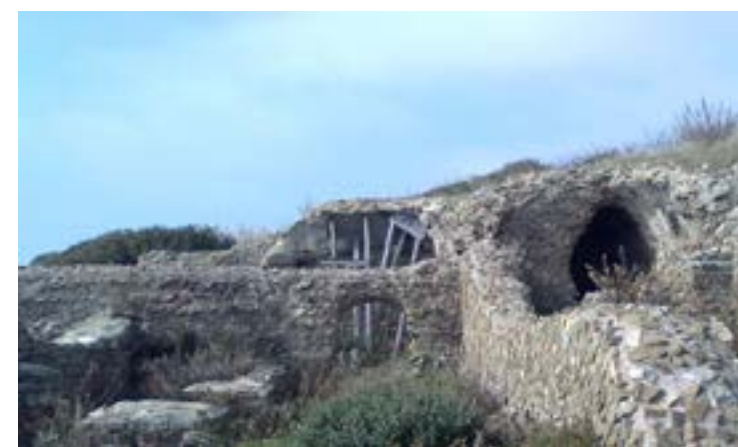
Fig. 14: tracce dei restauri effettuati alla villa.
