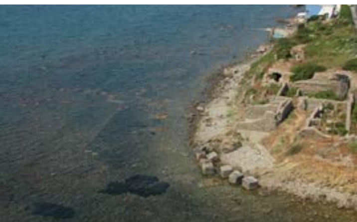
Fig. 12: il complesso della villa marittima delle Grottacce assieme alla peschiera di sua pertinenza.
