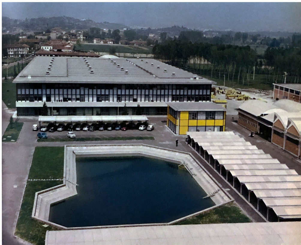
Fig.19: Vista aerea del polo di San Bernardo d'Ivrea scatta prima del 1960, anno dell'inizio lavori dell'Attrezzaggio. Nella parte destra dell'immagine è appena visibile l'edificio della Falegnameria. (Fonte: Musatti, 1958)
