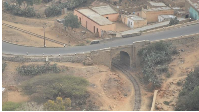
Cavalcavia in uscita dalla stazione di Nefasit (foto 2018)
