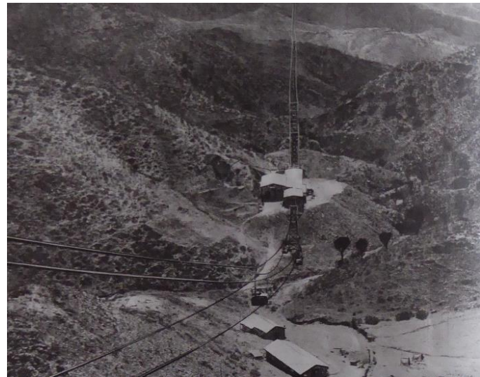
La stazione di Golei (tratto da La teleferica Massaua-Asmara, Ceretti&Tanfani S.A., Milano, p.28)
