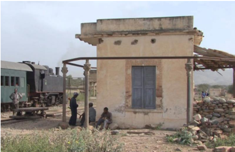
Stazione di Baresa (da filmato «Mallets in the mountain», 2009, 30'47'')
