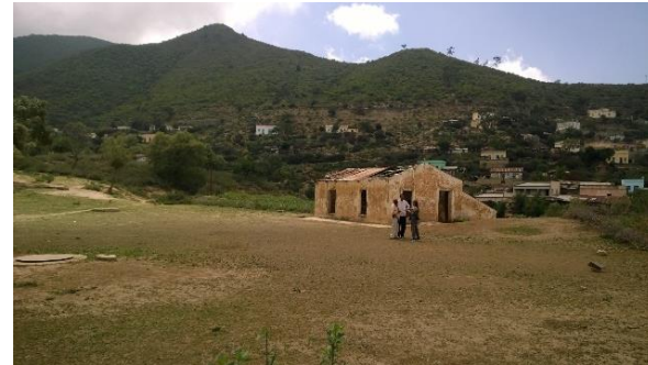
Foto del serbatoio ferroviario in muratura da 3.000 mc, a monte della stazione (foto 2018)
