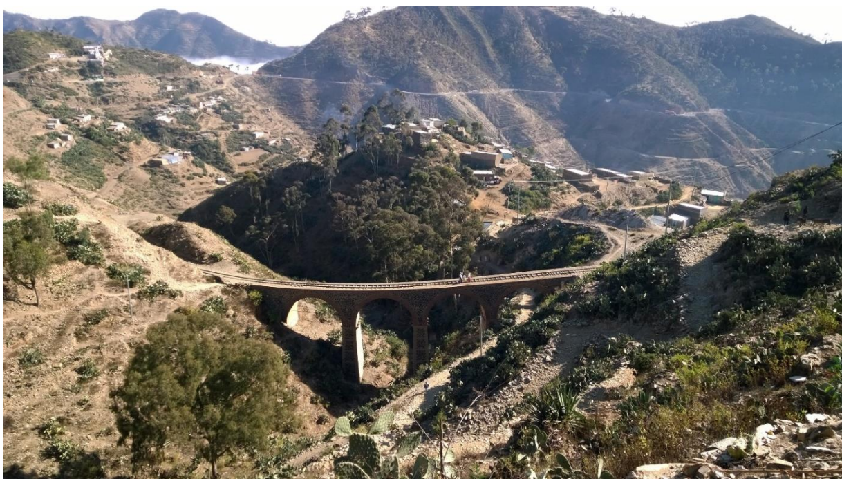
La strada ferrata è qui usata anche come sentiero (foto 2018).
