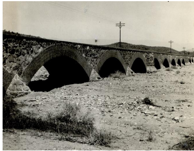
Ponte sul fiume Agbalo al km 20+703 da «Relazione sullo stato di conservazione dei ponti e dei viadotti della linea ferroviaria Massaa-Asmara» 1958
