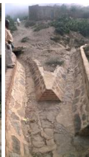
Cunette per la raccolta dell'acqua piovana all'Arbaroba
