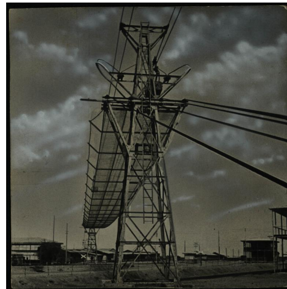
Ponte protettivo nei pressi della stazione di Otumlo (dall'album fotografico ISIAO 7/E BNCR-IsIAO)
