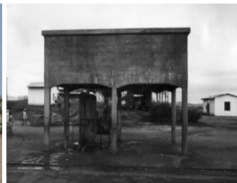
Serbatoio in cemento armato e depuratore «zerolite» alla stazione di Mai Atal (album fotografico del 1937 da www.ferrovieeritrea.it )
