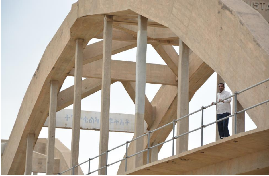
Il ponte di Dogali: è visivamente distinguibile uno degli interventi del progetto JICA sui copriferri del terzo tirante da destra. I corrimani in tubolari metallici furono montati nell'ambito del medesimo progetto (foto 2018).
