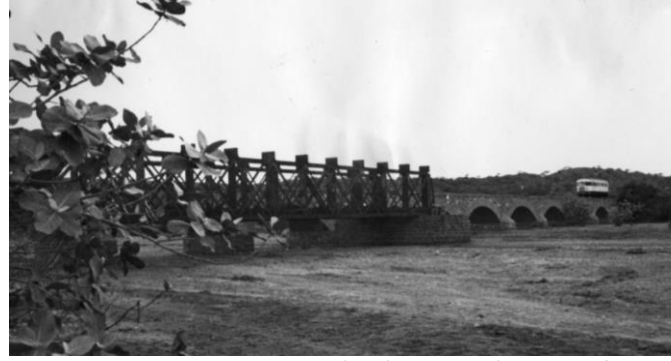
«Vecchio ponte sul Tamarisco» tratto da Album fotografico 1937, www.ferroviaeritrea.it . Si tratta dell'unico ponte in ferro usato tra Massaua e Asmara, risalente alla linea del 1887-88. Nella relazione Olivieri del 1888 è indicato come ponte «politragonale» secondo il brevetto Cottrau, realizzato a Castellammare di Stabia. Il ponte, inutilizzato già a inizio 900 era ancora visibile nel 1948.
