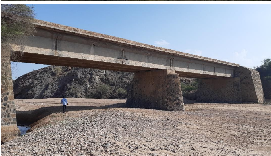
Il ponte in cemento armato a travata rettilinea realizzato nel 1935 su progetto di Guido Sassi nei pressi di Saati (foto 2019).
