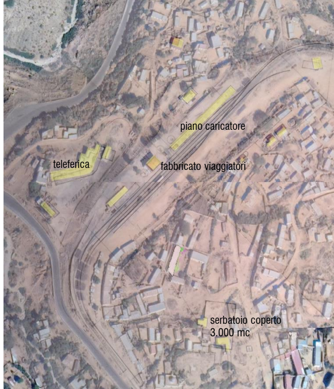
Estratto da Gmap 2019 con localizzazione degli edifici di pertinenza della stazione di Nefasit
