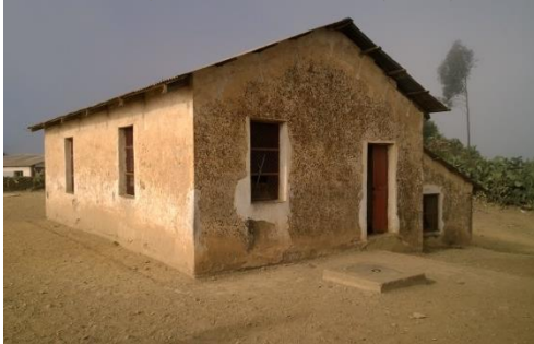
Esterno del vano di ispezione della cisterna di Arbaroba (foto 2018)
