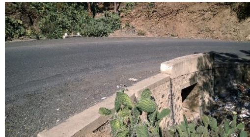
Sbocco di tombino nel tratto stradale tra Arbaroba e le Porte del Diavolo (foto 2018)
