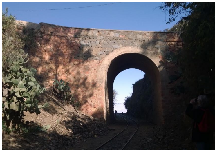
Sovrappasso nei pressi della stazione di Arbaroba: a sinistra tracce dell'allargamento in cemento armato della struttura in mattoni; molto probabilmente realizzato quando la rotabile fu trasformata in una camionabile che doveva garantire una percorrenza senza strozzature a doppio senso di marcia (foto 2018)
