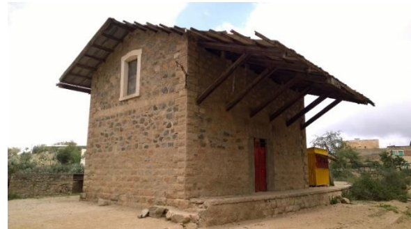
Foto del fabbricato ad uso deposito dell'impresa Brillante (foto 2018)
