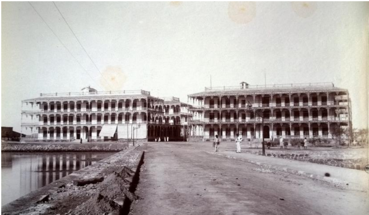
Le "famigerate" e costosissime palazzine coloniali, costruite sull'isola di Taulud in una posizione di grande visibilità per chi sbarcava a Massaua, avrebbero dovuto rappresentare l'opera italiana, ma furono demolite pochi anni dopo la costruzione per problemi strutturali dovuti alla scarsa conoscenza del comportamento del suolo madreporico (foto tratta dall'album "Ricordo Eritreo" – fotografo Nicotra Massaua 1898 BRT, P 45/11)
