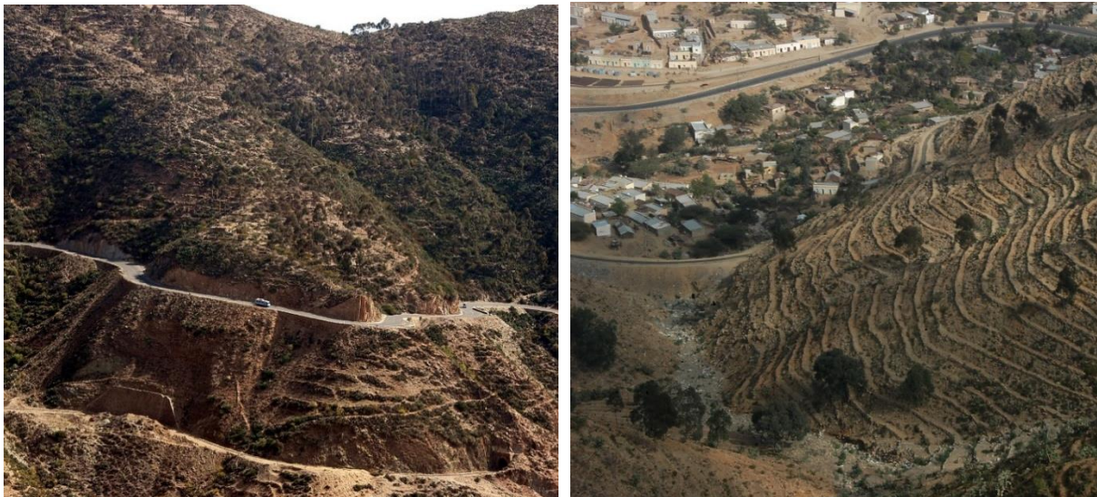
I versanti ripidi a monte e a valle della camionabile tra le Porte del Diavolo e Arbaroba, e il basilare sistema di pseudoterrazze a monte del villaggio di Nefasit per ridurre la caduta di detriti sulla linea ferroviaria e sull’abitato (foto di Alfredo Castiglioni, 2012).
