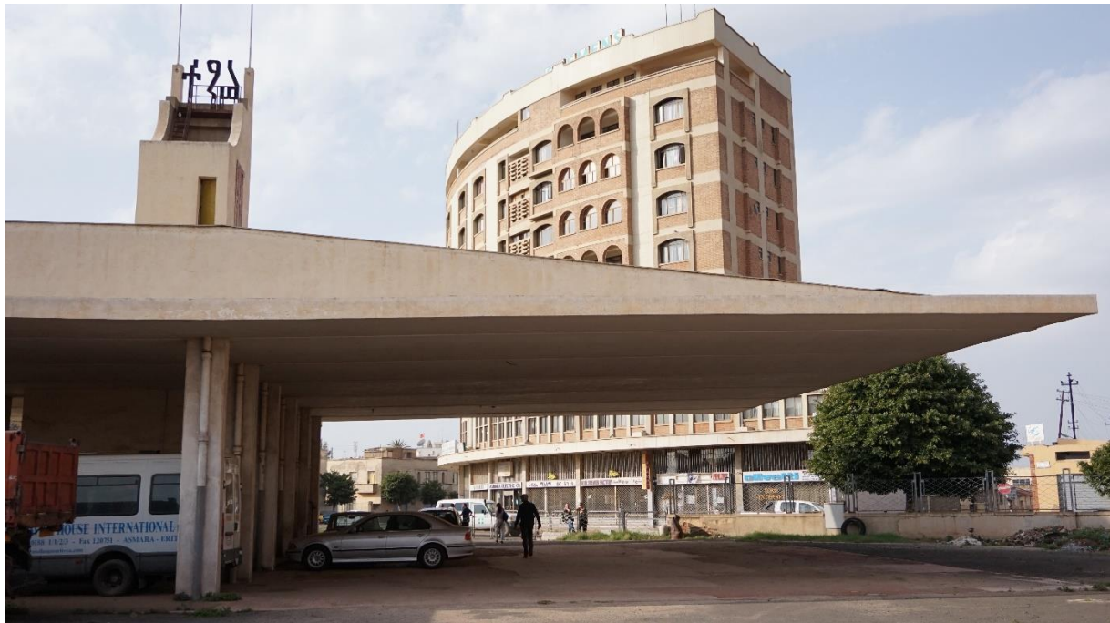
Il Nakfa building, costruito negli anni novanta quasi a ridosso dell'edificio noto come "Fiat Tagliero" del 1938 (foto 2016).
