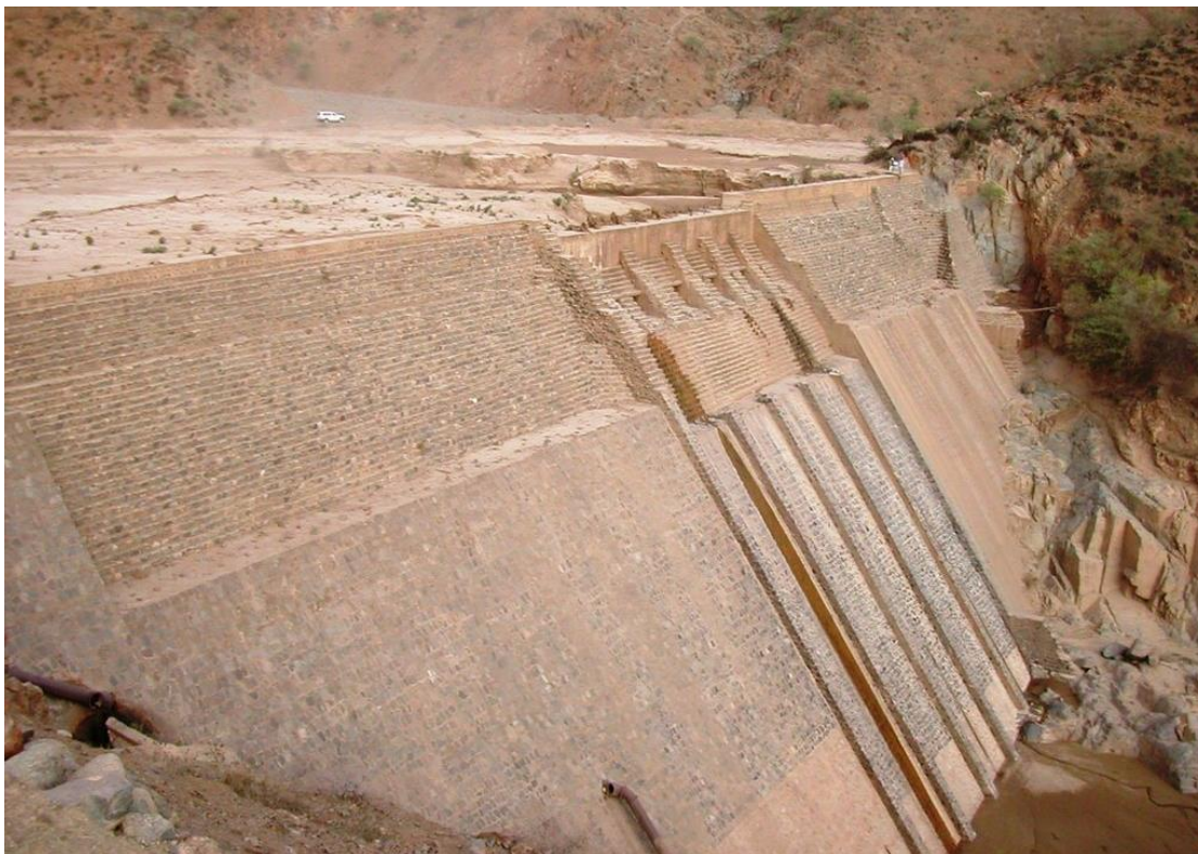
Recente foto della diga in cui è visibile che l'invaso è completamente saturato dai materiali di deposito (risorsa online https://mapio.net/pic/p-26341578/ ).
