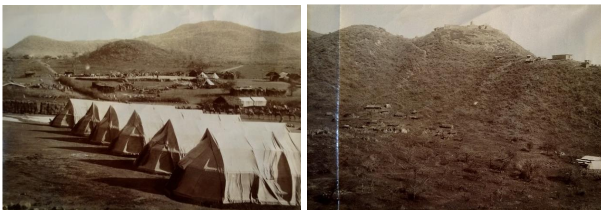
A sinistra "Ghinda – comando di tappa", a destra il "Forte Nido d'Aquila" negli anni novanta dell'Ottocento (dall'album "Ricordo Eritreo" Nicotra fotografo Massaua, BRT, P 45-11).
