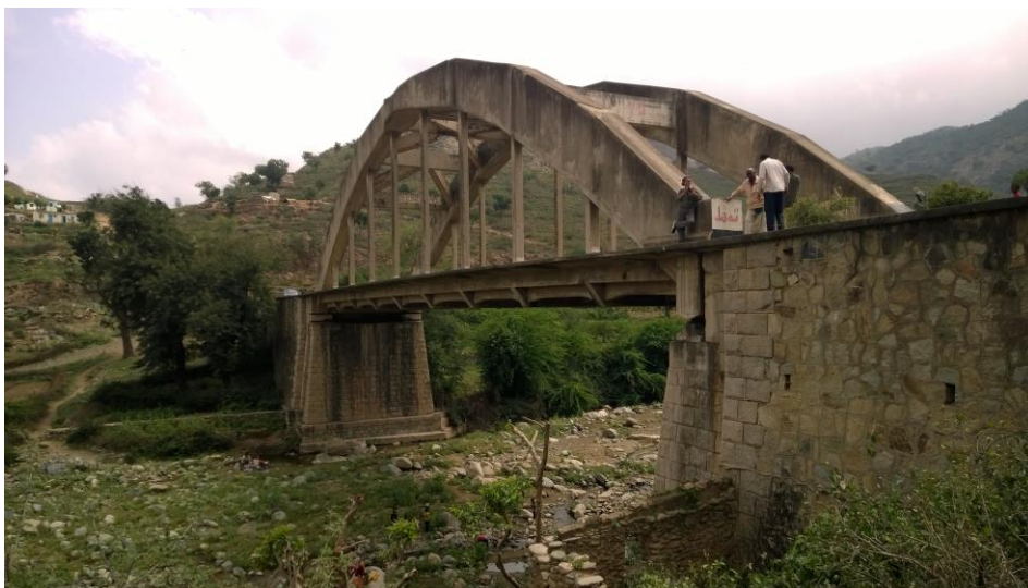
Il ponte di Ghinda (foto 2018) dal 2004 sopporta un traffico ridotto dalla realizzazione nell'ambito del progetto JICA di un ponte a valle, e di una circinnallazione del centro abitato.
