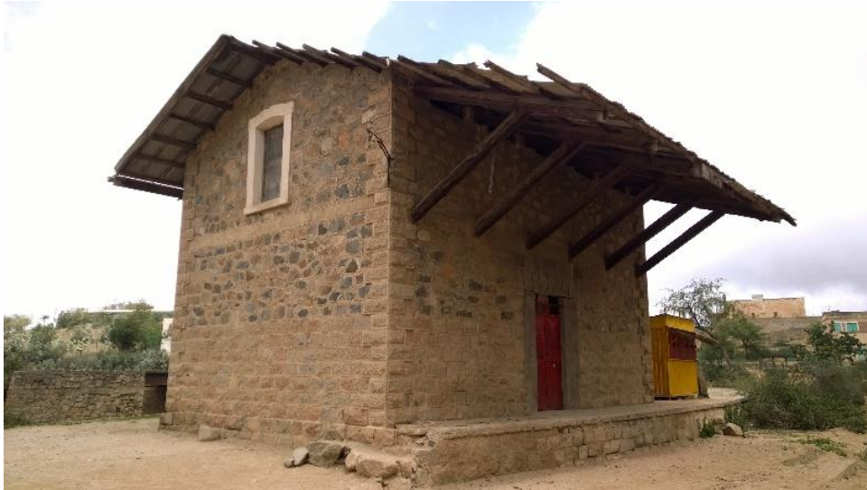
Il deposito della ditta Brillante all'interno dell'area della stazione di Embatcalla (foto 2018).
