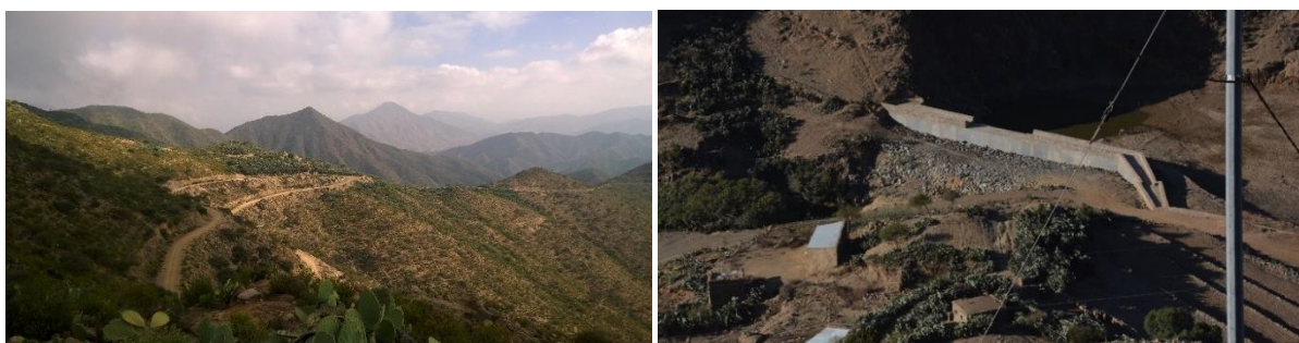
La strada e gli sbarramenti nella valle del Golei visti dalla camionabile (foto 2018, foto a destra di Dawit Abraha).
