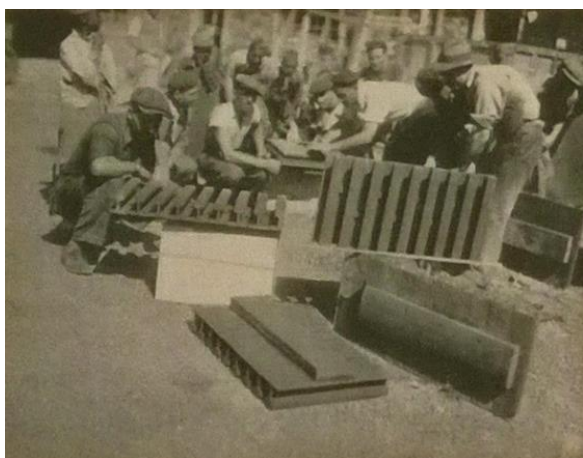
Immagini tratte da SASSI G., "La realizzazione pratica degli elementi di isostaticità nelle strutture dei ponti quale fu ottenuta in Etiopia nei maggiori ponti in cemento armato. Capitolo II - Gli apparecchi di dilatazione", estratto da L'ingegnere, n.2-3, Milano, 1940 pp. 10 e 9. Si possono vedere le porzioni di rotaie utilizzate.
