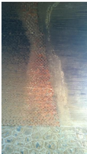
Sovrappasso nei pressi della stazione di Arbaroba: a sinistra tracce dell'allargamento in cemento armato della struttura in mattoni; molto probabilmente realizzato quando la rotabile fu trasformata in una camionabile che doveva garantire una percorrenza senza strozzature a doppio senso di marcia (foto 2018)
