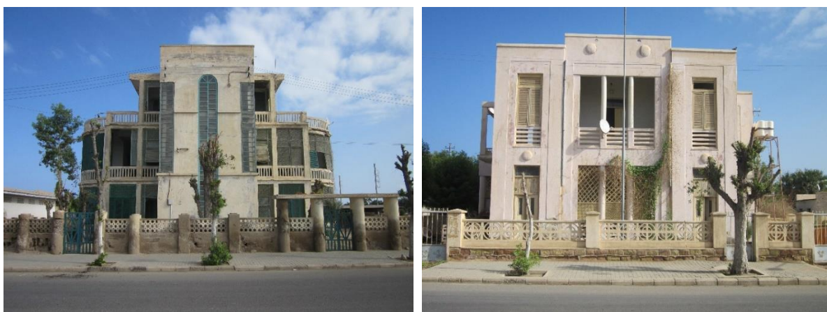
Due esempi di palazzine costruite negli anni trenta sull'isola di Taulud-Massaua. I volumi integrano le logge chiuse dalle musharabie necessarie a controllare il clima interno (foto 2018).
