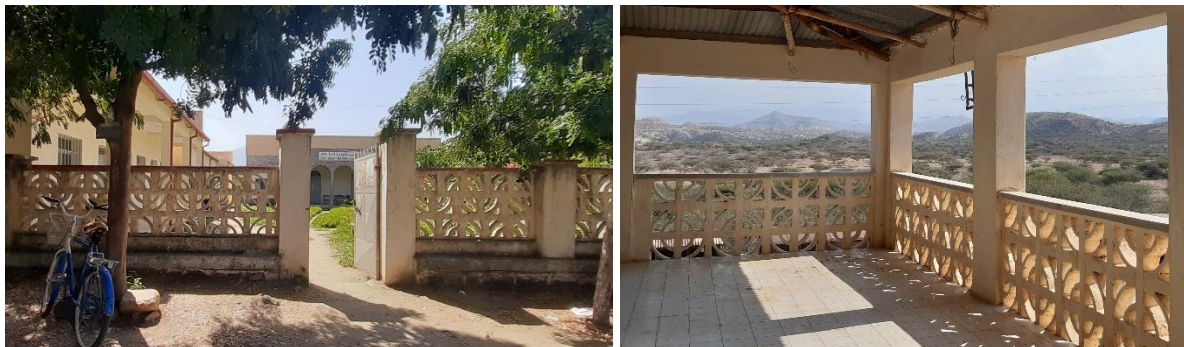
I diffusissimi blocchetti in cemento tipo Nicaragua, sono tuttora molto usati in tutta l'Eritrea per realizzare recinzioni, balaustre, chiusure e oscuramenti delle verande (a sinistra recinzione a Ghinda, parapetto del fabbricato viaggiatori della stazione ferroviaria di Mai Atal, foto 2019)
