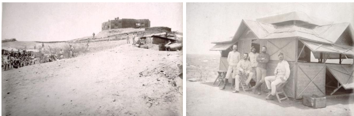
A sinistra un fortino metallico smontabile tipo "Spaccamela" installato a Dogali, a destra il sistema in telai di legno e stuoie utilizzato per costruire rapidamente i baraccamenti militari (BRT, FOT II-11/2).
