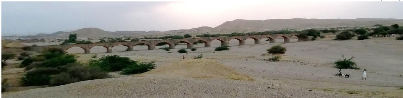
Ponte sul torrente Uissa (foto 2018)
