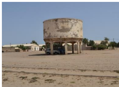
Cisterna d'acqua in cemento armato (foto 2018).
