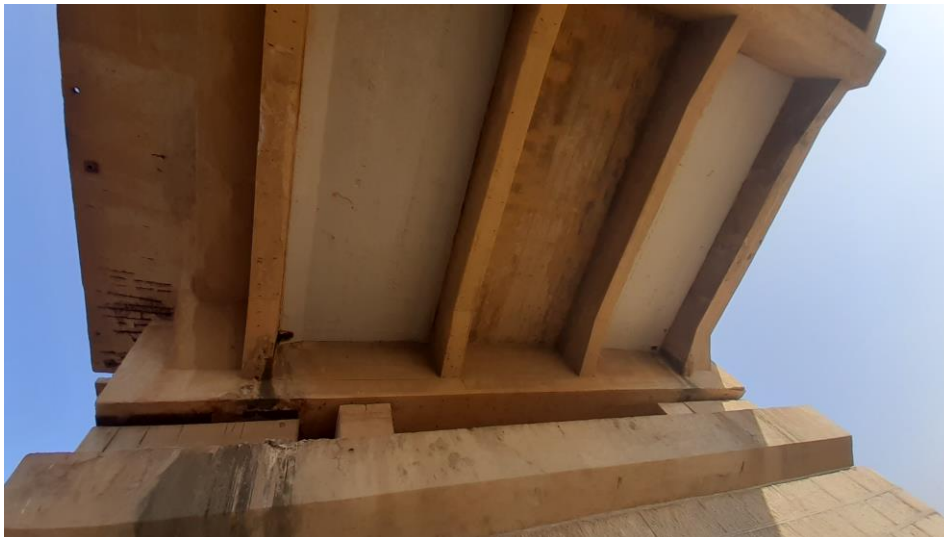
Il ponte di Dogali: sono visibili i trattamenti protettivi posati sull'intradosso del piano stradale nell'ambito del progetto JICA (foto 2018).
