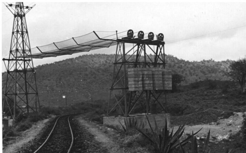
«Ponte protettore sopra la stazione di Ghinda» (dall'album fotografico ISIAO 7/E BNCR-ISIAO)
