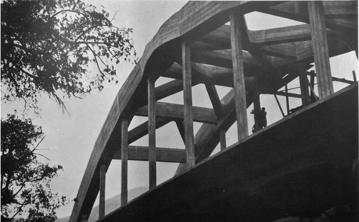
Foto tratta dal volume La camionabile... , 1936, p. 59, la didascalia originale descrive così la struttura: "un armonioso e robusto intreccio di membrature di un ponte in cemento armato".
