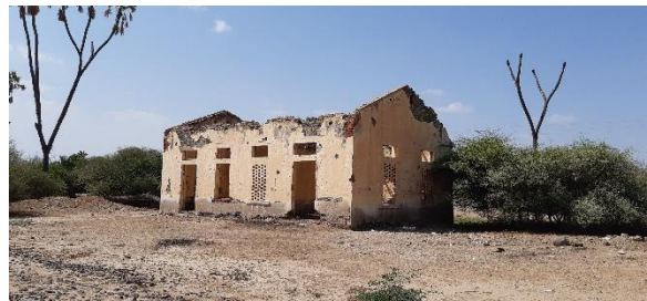
Il fabbricato viaggiatori della stazione di Dogali (2019)
