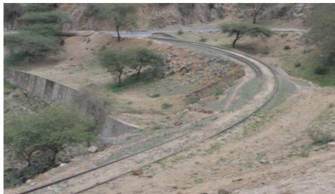
Rilevato con muro, tra Ghinda e Nefasit (foto 2018)
