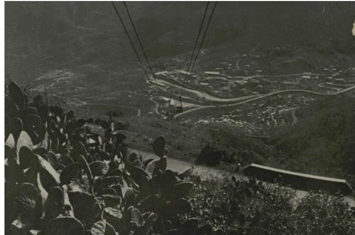
Stazione Teleferica Nefasit e strada camionabile (dall'album fotografico IsIAO 7/E BNCR-IsIAO). Si può constatare che la strada non è dotata di ponti protettori.
