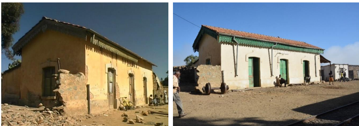
L'attività di recupero della linea coinvolse anche parte degli edifici di pertinenza della ferrovia: qui si vede la stazione di Arbaroba nel 2003 e nel 2018 (a sinistra fotogramma al 56'43", del video Ritorno all'Asmara" di Gianfranco Berto, a destra foto 2018).
