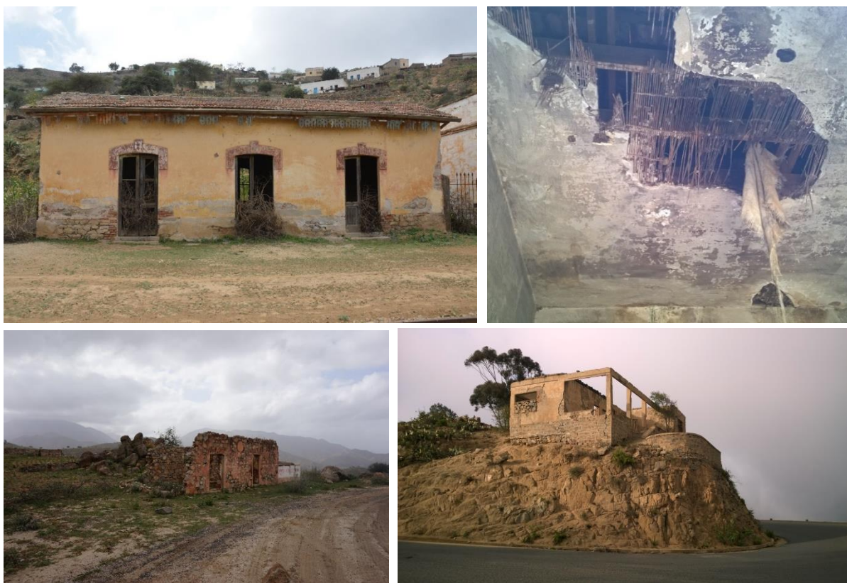
Sopra: la stazione ferroviaria di Embatcalla non è ancora stata sottoposta a interventi di recupero, e presenta ben visibili materiali e tecniche costruttive tipiche dell'edilizia italiana di fine Ottocento-inizio Novecento. Sotto a sinistra l'edificio in stato di rudere di una vecchia tappa lungo la rotabile, poi camionabile, all'ingresso di Ebatcalla, a destra la casa cantoniera al km 16 (foto 2016-2018).
