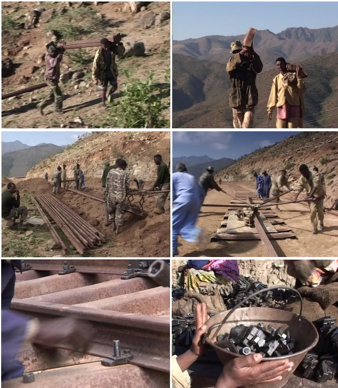
Immagini tratte dal documentario "Eritrea – Rebirth of a Railway" (autore Nick Lera, 2004) ai minuti 15.33, 15.46, 15.58, 18.36, 17.04, 17.34. Dall'alto: il recupero del materiale di armamento dai dintorni, la posa di traversine e rotaie e il raddrizzamento di queste tramite gli utensili di inizio Novecento (nella quarta immagine si vede il "girarotaia"), sotto i bulloni e le piastrelle per il fissaggio delle rotaie alle traversine, che fu necessario acquistare in Italia.
