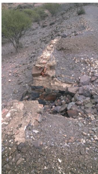
Resti di un tombino e del muro di sostegno della vecchia rotabile (foto 2018).
