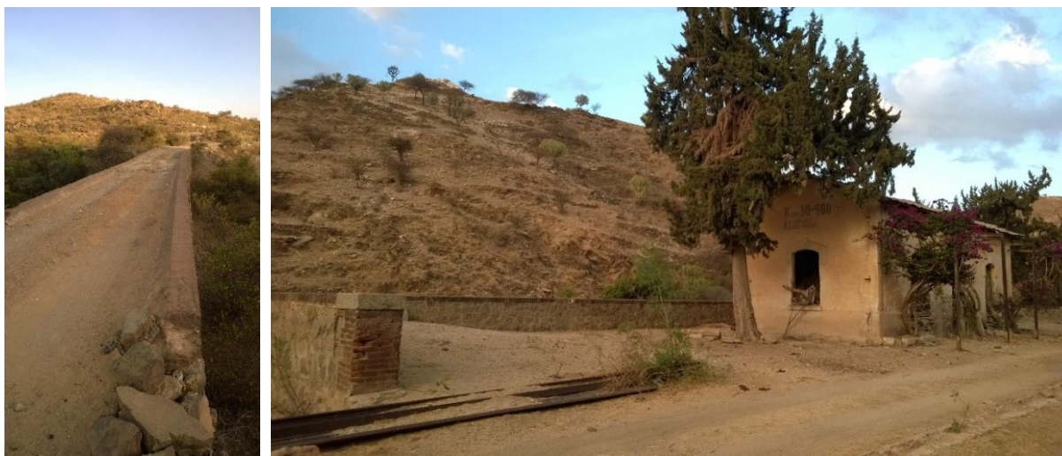
Tratto (tra le progressive chilometriche 20 e 30 dalla capitale) della linea oltre Asmara in direzione di Cheren, che si presenta tuttora priva di ballast e di armamento. A sinistra un ponte ferroviario, a destra l'edificio della stazione ferroviaria di Dem Sebai (foto 2018).
