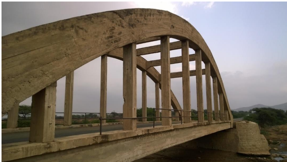
Il ponte di Sabarguma o Gathelay 2, in uso (foto 2018).
