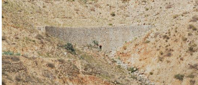
Acquedotto nei pressi di Nefasit (foto 2018)
