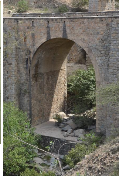
«Ponte a volta in muratura luce 12,00 m.» Tav. 69-70, in MIOZZI E., Manufatti stradali: cinquecento tavole di disegni esecutivi con prospettive, particolari, computi metrici di opere costruite e collaudate - Vol.I, Hoepli, Milano, 1929
