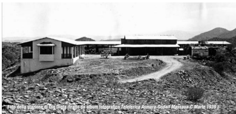
«La stazione di Dig Dig[ta]; osservare a destra la linea aerea, che oltrepassato il vallone riappare sulla cresta dello sfondo» (tratto da La teleferica Massaua-Asmara , Ceretti&Tanfani S.A., Milano, p.23)
