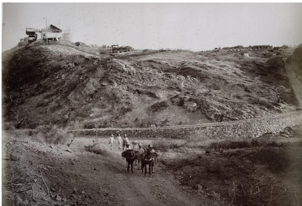
“Saati. Forte Sud La curva della Decauville [sic]” in album fotografico “L. Fiorillo fotografo della corte Alessandria (Egitto)” BRT Fot. II 11/2. In primo piano si vede la rotabile, appena dietro, ai piedi dell’altura su cui sorge il forte sud in costruzione, si vede la struttura sui cui ha sede la linea decauville diretta al forte nord.
