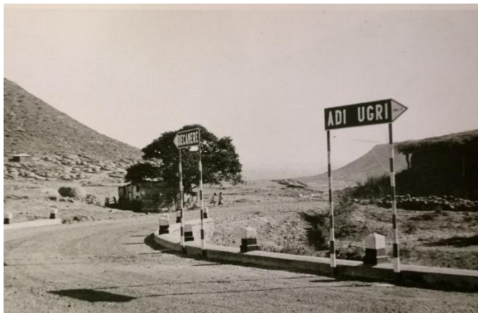
Foto degli anni quaranta in cui è possibile osservare i cartelli segnaletici in uso lungo le strade realizzate negli anni 1935-37 in Eritrea (ATCI). Si può vedere anche il cordolo in calcestruzzo di cemento con pilastri segnaletici.
