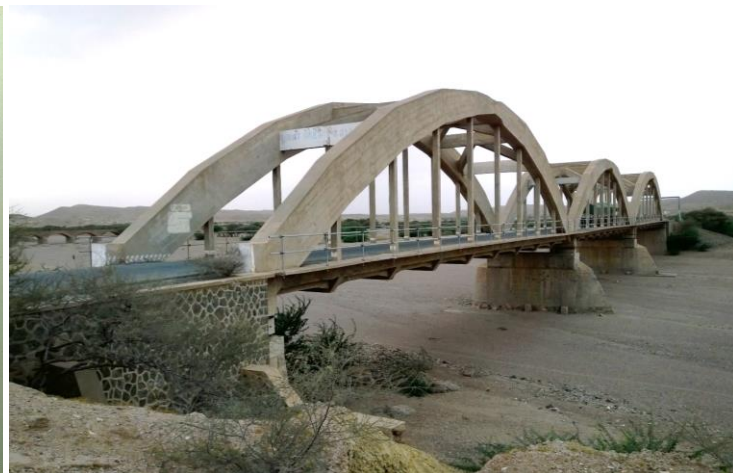
Il ponte ad arco a via inferiore in cemento armato di Moncullo realizzato su progetto dell'ing. Guido Sassi (foto Dawit Abraha 2018)
