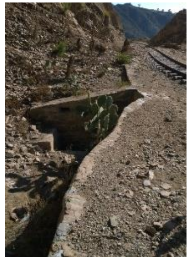
Imbocco di un tombino nei pressi di Arbaroba (foto 2018)
