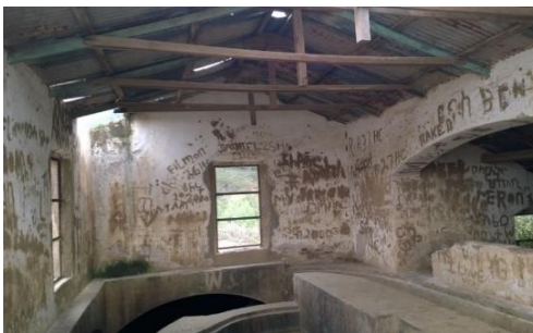
Interno del vano di ispezione della cisterna di Embatcalla (foto 2018)
