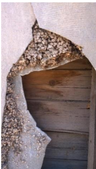
I padiglioni sanitari nei pressi di Embatcalla, costruiti con sistemi semiprefabbricati (foto 2018, foto d'epoca tratta dagli "Annali dell'Africa Italiana")
