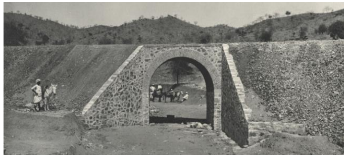
«Ponticello al km 19,278», tratto dall'album fotografico «Colonia Eritrea. Ferrovia Dig. Digta – Ghinda» 1902-1904, IsIAO_1169, BNCR
