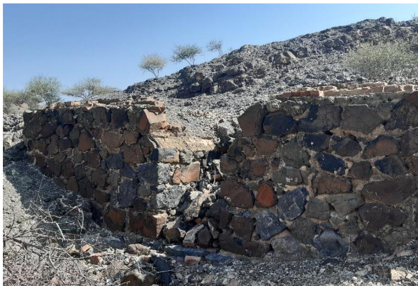
Resti di un tombino e del muro di sostegno della vecchia rotabile (foto 2018).
