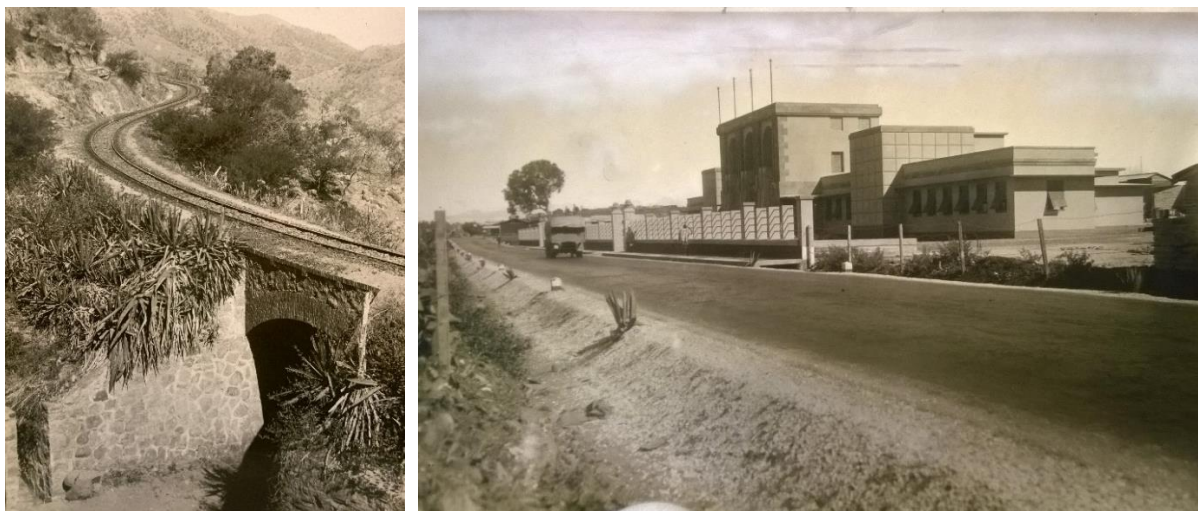
In queste due foto degli anni quaranta (da AHP, archivio fotografico) si può vedere l'impiego dell'agave per consolidare le massicciate ferroviarie e stradali.
