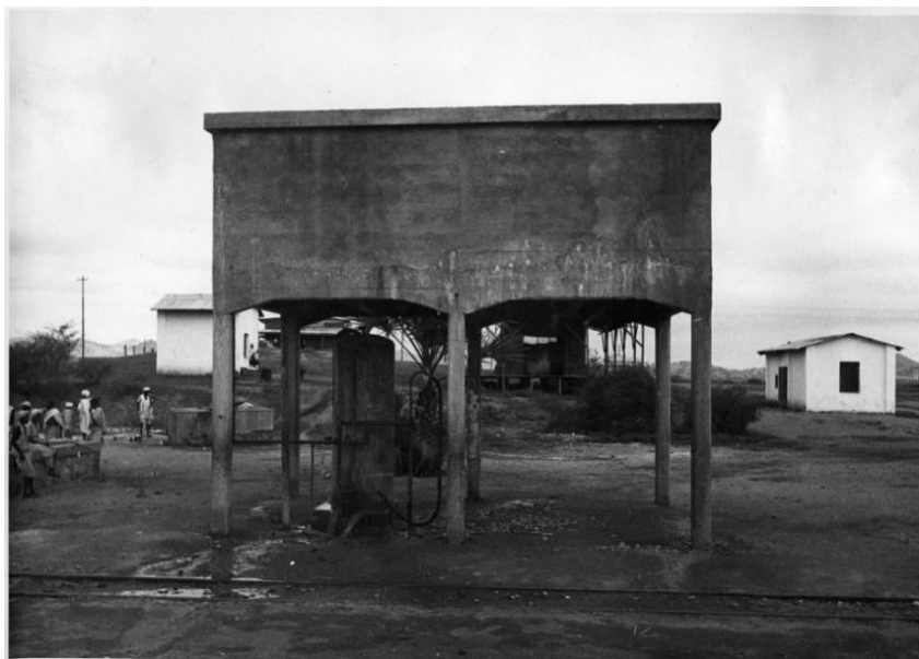
Serbatoio in cemento armato con purificatore Zerolit alla stazione di Mai-Atal ("Ferrovia Massaua-Asmara-Keren-Agardat-Biscia 1939. Album" tratto da www.ferroviaeritrea.it a cura di Stefano Pettini).
