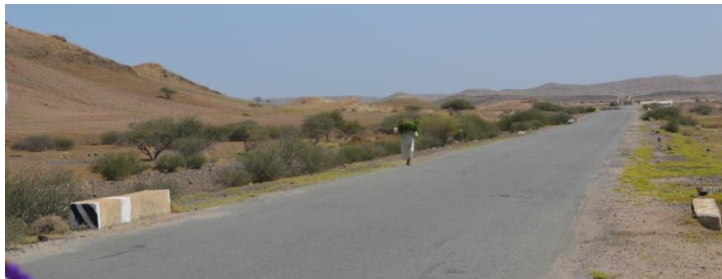
La strada Massaua-Asmara nella piana di Sabarguma: si possono osservare a bordo strada i muretti di protezione all'altezza dei tombini, che di fatto interrompono la scarpa (foto Raffaella Russo 2018).
