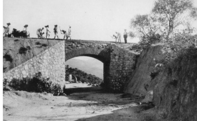
«Sottopassaggio della strada carrozzabile alla sella di Embatkalla km 84,3» («Ferrovia Massaua-Asmara» Dainesi, 1911). Non è chiaro se si tratti del sottopassaggio demolito negli anni 1990 per permettere il passaggio degli autocarri o se fosse già stato rifatto contestualmente alla camionabile del 1935.
