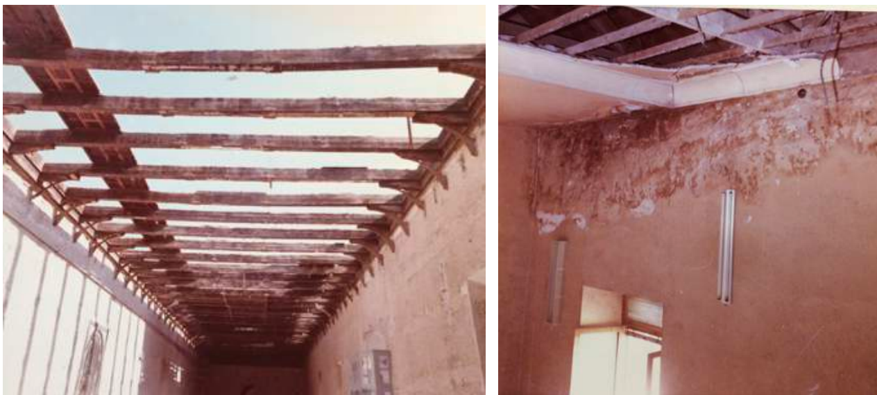
Imagen 29.- Hospital Central. Desmonte de cubiertas, 1969.
