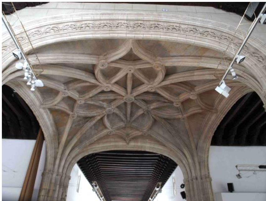
Imagen 46.- Hospital Real de Granada. Bóveda del crucero bajo. Fuente: fotografía de la autora, 2017
