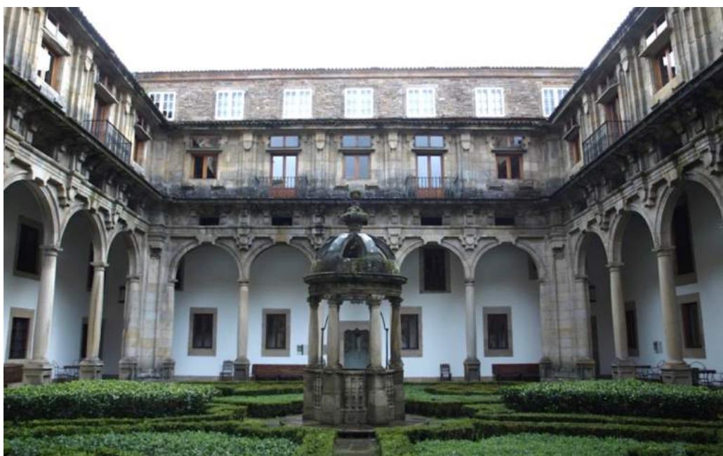
Imagen 17.- Hospital Real de Santiago de Compostela. Patio "de abajo" con el pozo en el centro. Fuente: fotografía de la autora, 2018
