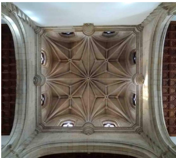
Imagen 26.- Hospital Real de Santiago de Compostela. Bóveda del crucero central.
