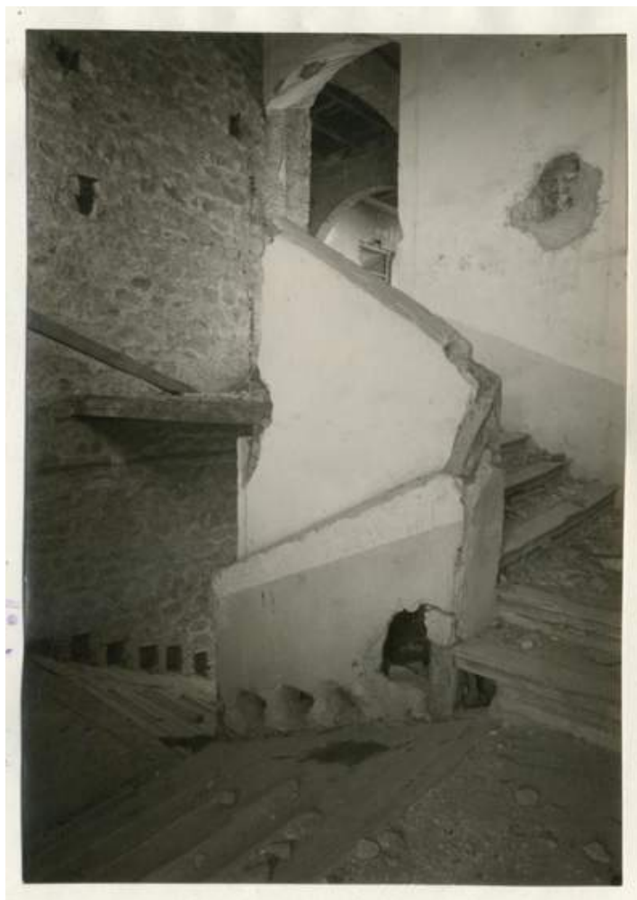
Imagen 37.- Estado de la escalera del segundo patio que se proyecta restaurar, 1934. Fuente: A.G.A. Caja 31/04893 Exp. 005
