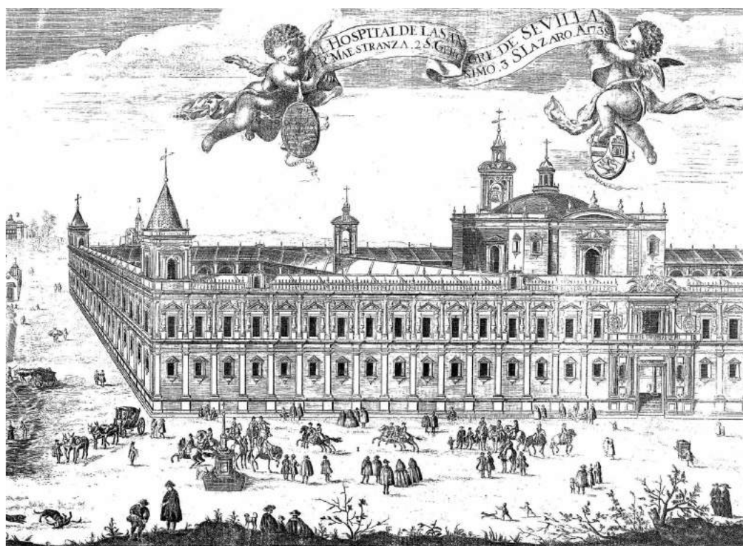
Imagen 27.- El Hospital de la Sangre de Sevilla. Pedro Tortolero, 1738. Fuente: AA.VV. El edificio sede del Parlamento de Andalucía: el Hospital de las Cinco Llagas, 2007
