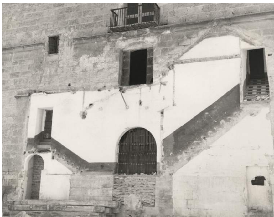
Imagen 15.- Hospital Real: fachada occidental tras la demolición de edificios anejos, 1965. Fuente: A.G.A. / 26-00350-001
