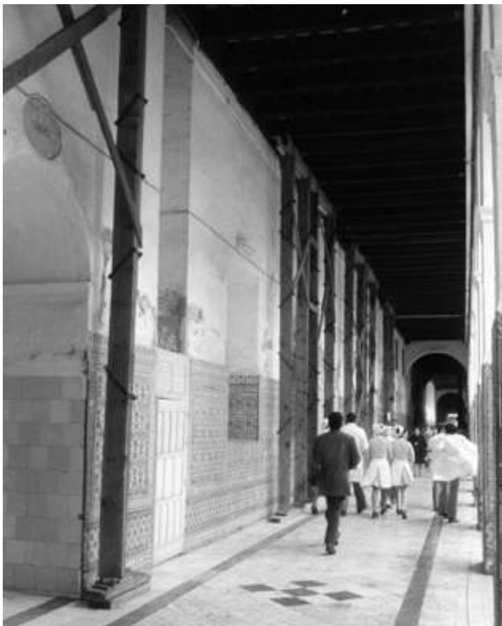
Imagen 31.- Salas y pasillos apuntalados, 1972. Fuente: A.M.Se. SAHP / ge18_ms-h1_72_001_02-2
