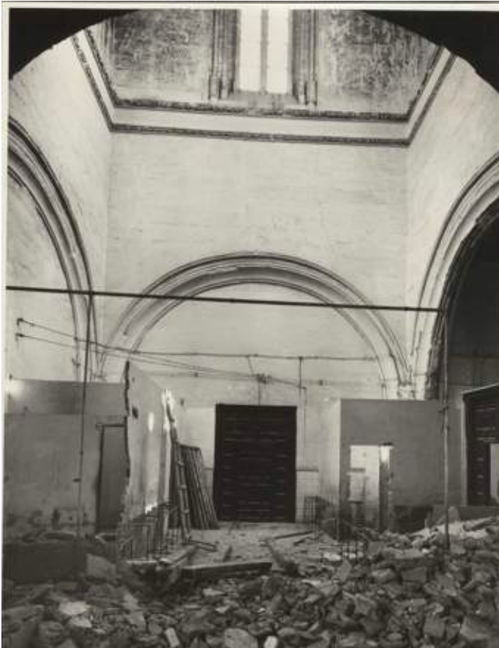
Imagen 13.- Hospital Real de Granada. Obras en el crucero superior, 1962. Fuente: A.G.A. / 26-00374-001
