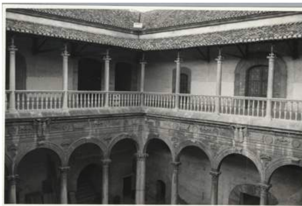
Imagen 21.- Hospital Real: Ángulo Suroeste del patio, 1980. Fuente: A.G.A. / 26-01162-001
