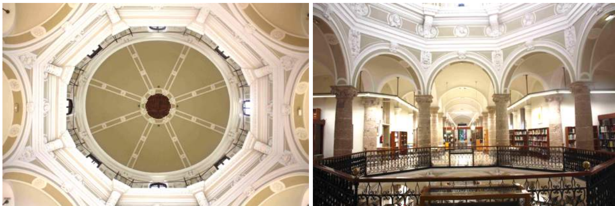
Imagen 20.- Vista actual del octógono central de antiguo hospital.
