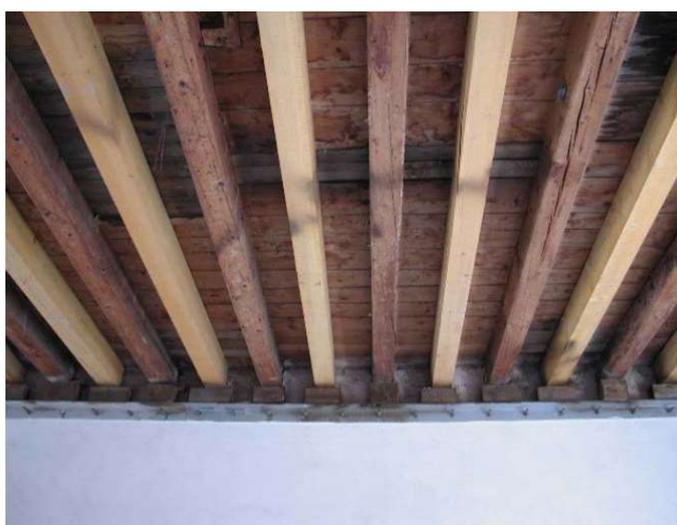
Figura 7.3 Esempio di raddoppio travetti lignei [20]
