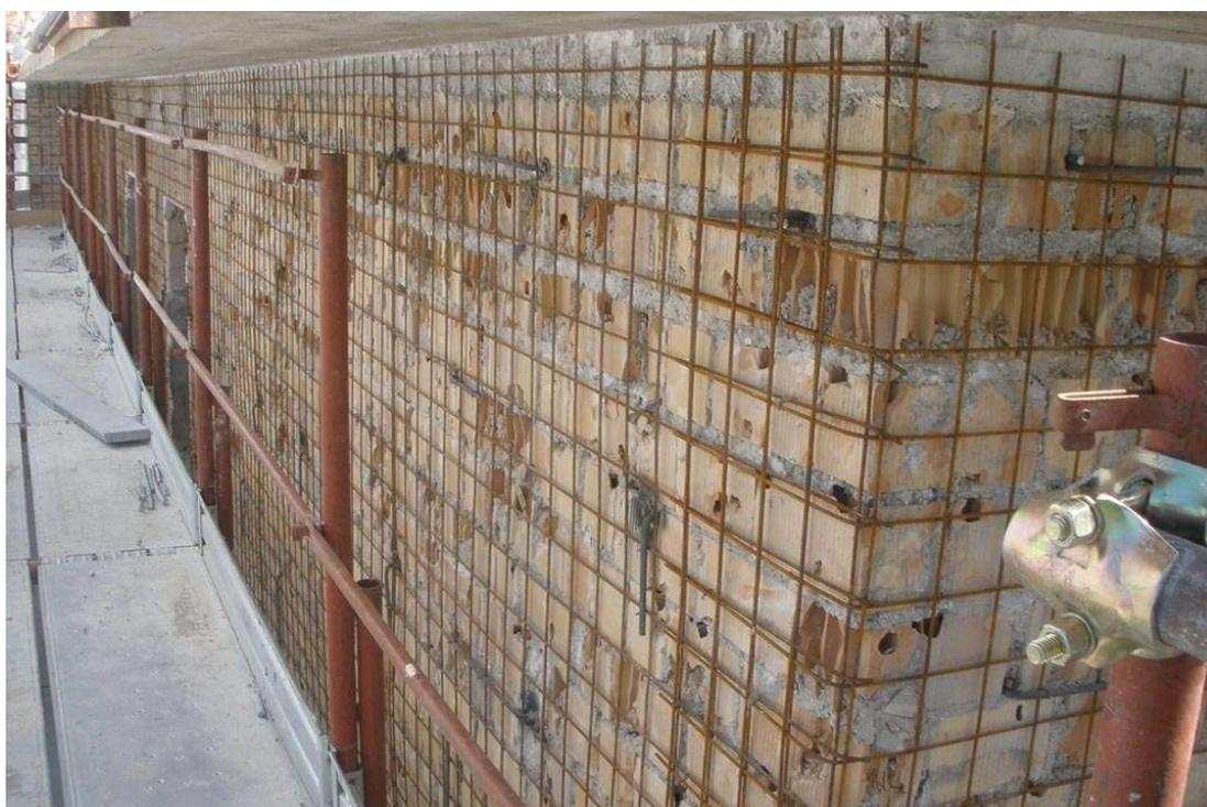
*Figura 6.12 Esempio applicativo di intervento con intonaco armato*
