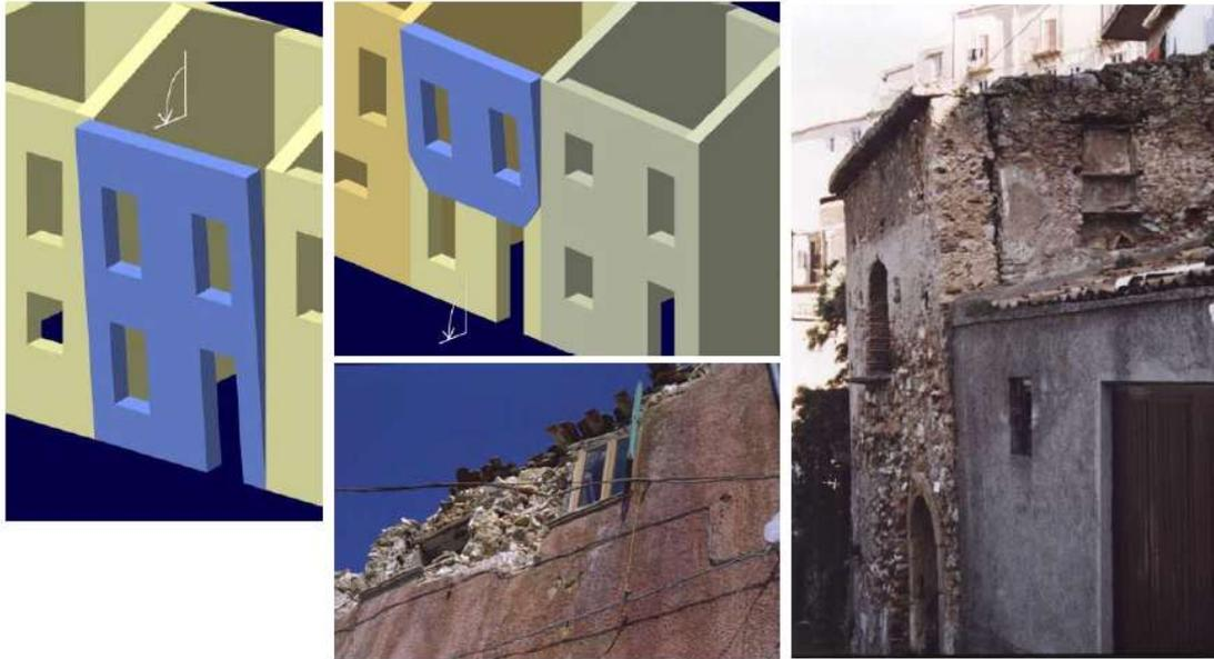
*Figura 4.6 Schematizzazione e foto di ribaltamento semplice*
