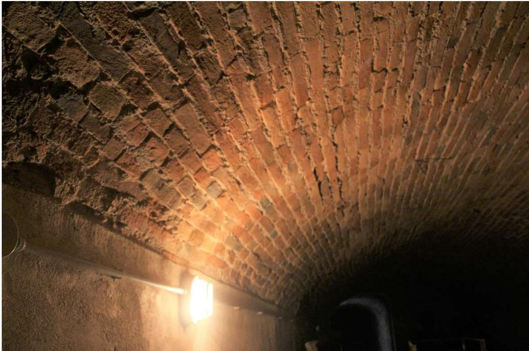
*Figura 2.8 Dettaglio volta a botte piano interrato*
