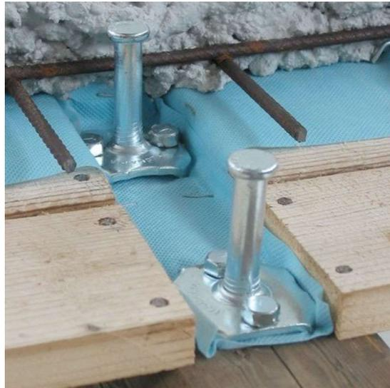
*Figura 7.7 Esempio connessione solaio misto legno-calcestruzzo [21]*
