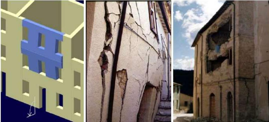
*Figura 4.1 Schematizzazione e foto di flessione verticale*
