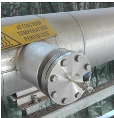
Figura 40: Bocchello per il campionamento
