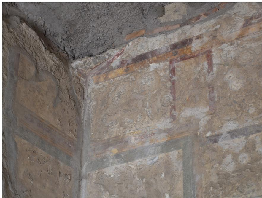
Fig. 44 (su) Angolo NE dell'ambiente M, in prossimità dell'attacco della volta. Si noti i resti di affresco con cornici di finte strutture architettoniche. Questo è l'unico punto in cui si è conservata una piccola porzione di cornice che definiva la curvatura delle volte. Da qui probabilmente si è dedotto negli anni '50 la forma a sesto ribassato col quale è stata ricostruita.
