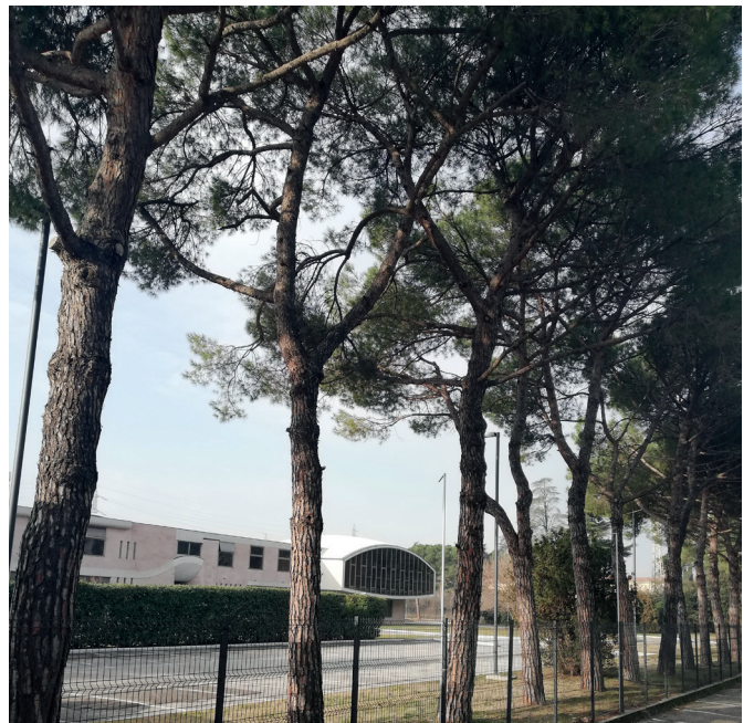
In alto, vista aerea del complesso ex Autogerma. In basso a sinistra, parcheggio sterrato che separa il complesso dall'abitato, a destra, vista del "disco volante".
