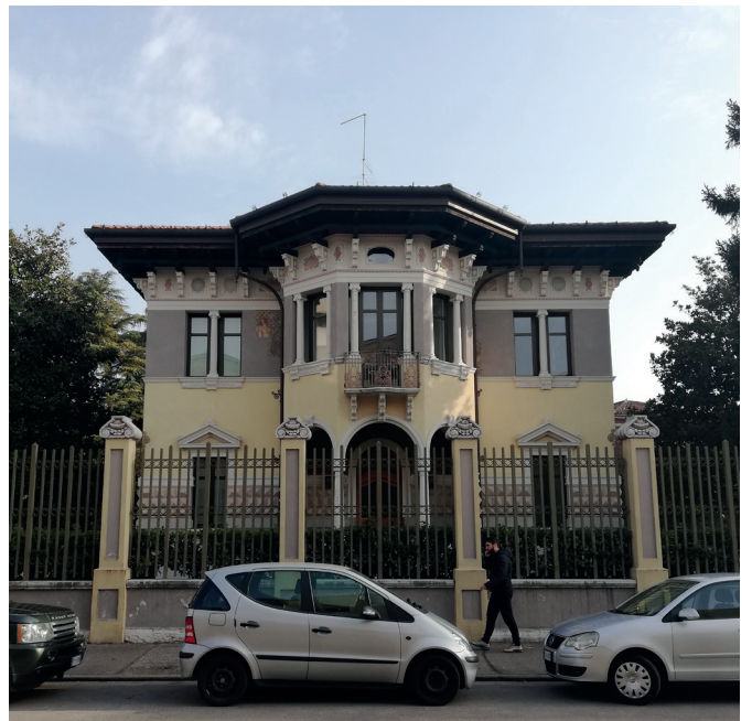
In alto, vista aerea di via Santa Teresa e di un tratto di via Scuderlando. In basso a sinistra, vista di via Santa Teresa dove i condomini affacciano sugli ex Magazzini Generali, a destra, villa liberty incastonata tra alti edifici.
