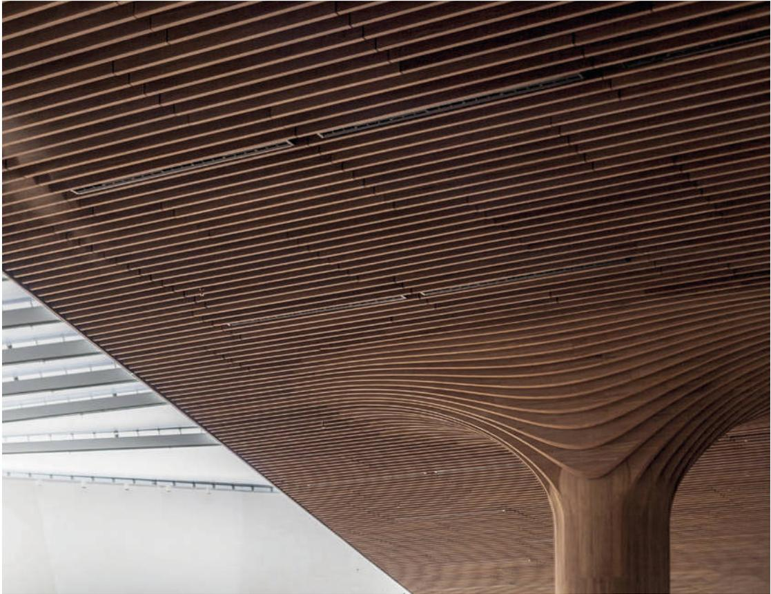
*Fig. 58: il bamboo MOSO è stato utilizzato per gli interni del centro commerciale di City Life, Milano. Fonte: [www.ifdm.design/2017/11/30/citylife-shopping-district-opens-in-milan-designed-by-zaha-hadid-architects/?lang=en](http://www.ifdm.design/2017/11/30/citylife-shopping-district-opens-in-milan-designed-by-zaha-hadid-architects/?lang=en)*
